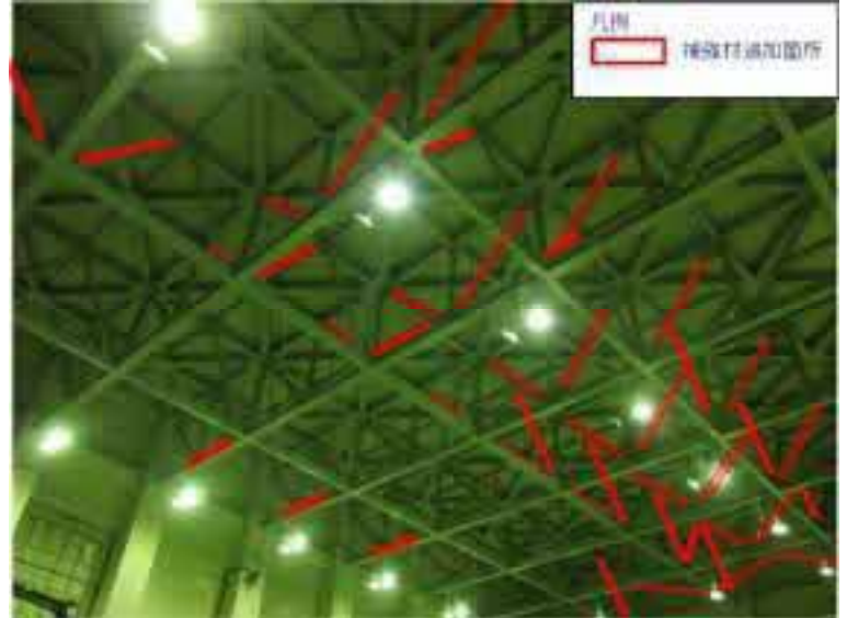
原子炉建物耐震補強工事状況
