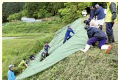
設置作業の様子(日野町黒坂、6月2日)
