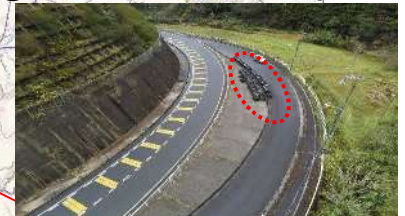
< 日野町管内対応用土のう仮置場 >
