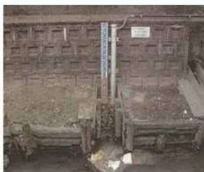
水位計設置状況
