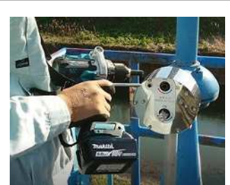
電動ドリルでの作業状況
