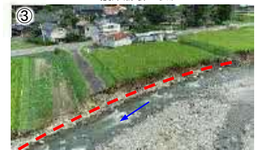
▲護岸崩壊の状況
