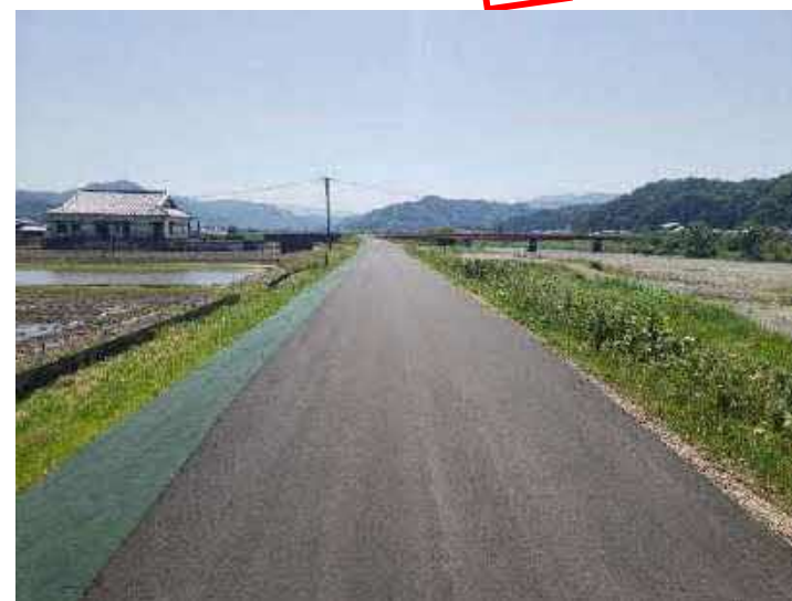
R4施工箇所：八東川（八頭町）
