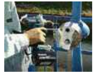
電動ドリルでの作業状況
