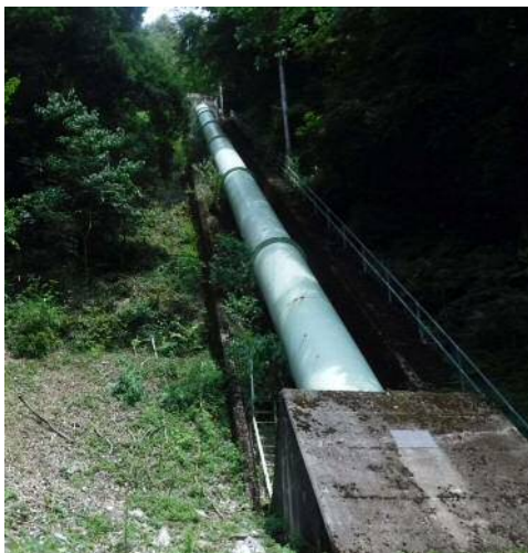
<水圧鉄管の外観>
