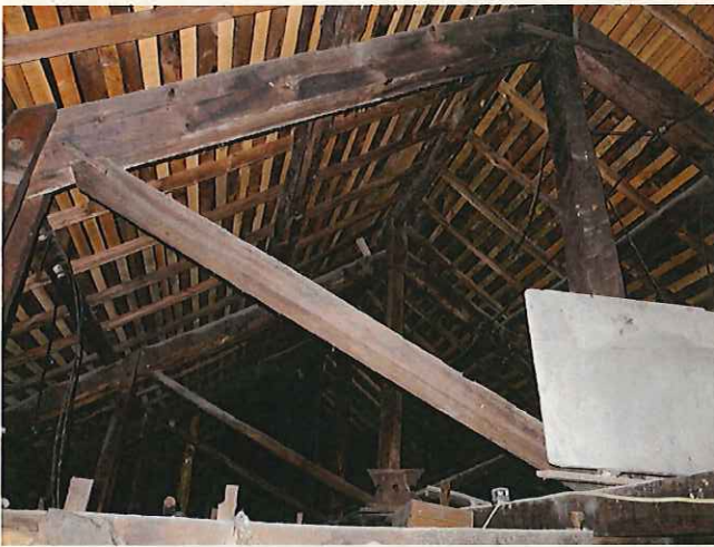
小屋組のトラス構造
