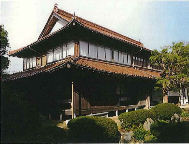
矢城家住宅主屋 外観
