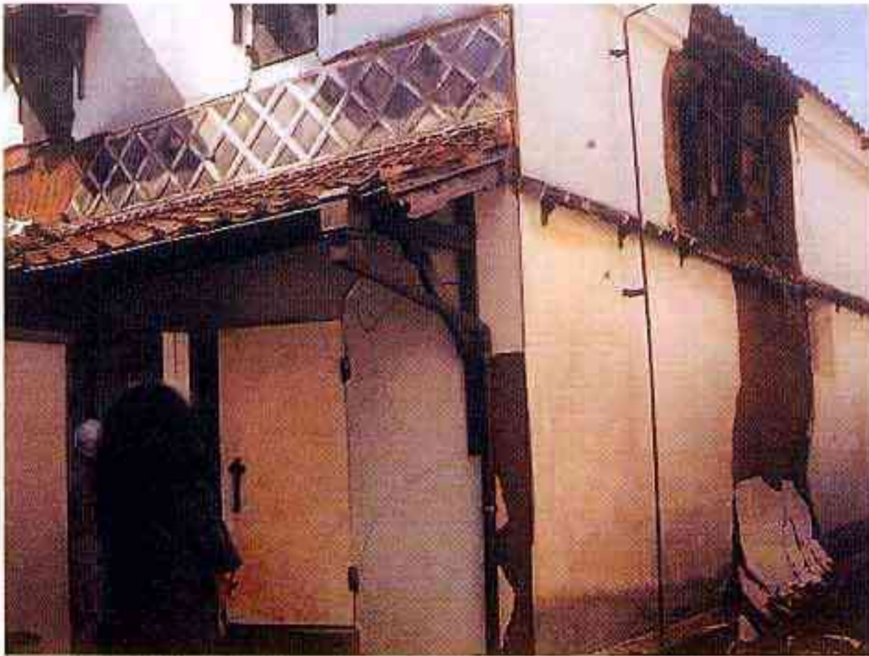
国指定重要文化財 後藤家住宅 蔵の壁の剥落、土壁の崩壊（米子市）
