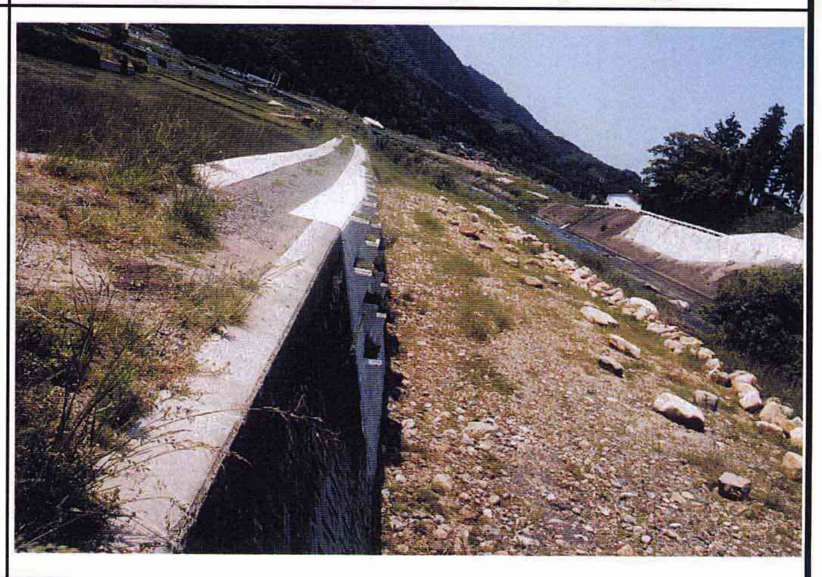
復旧状況写真
