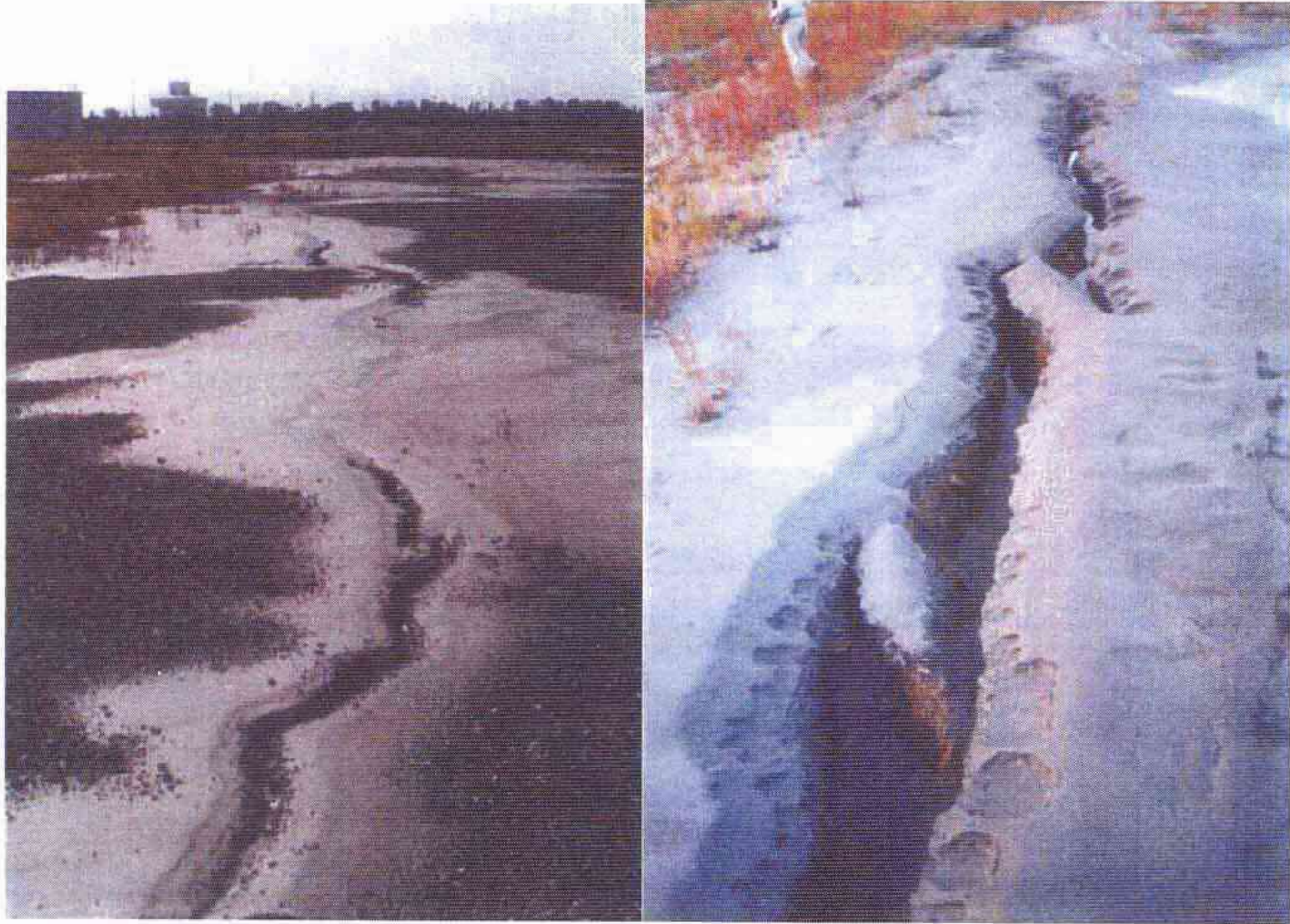
開口クラックに見られる噴砂
