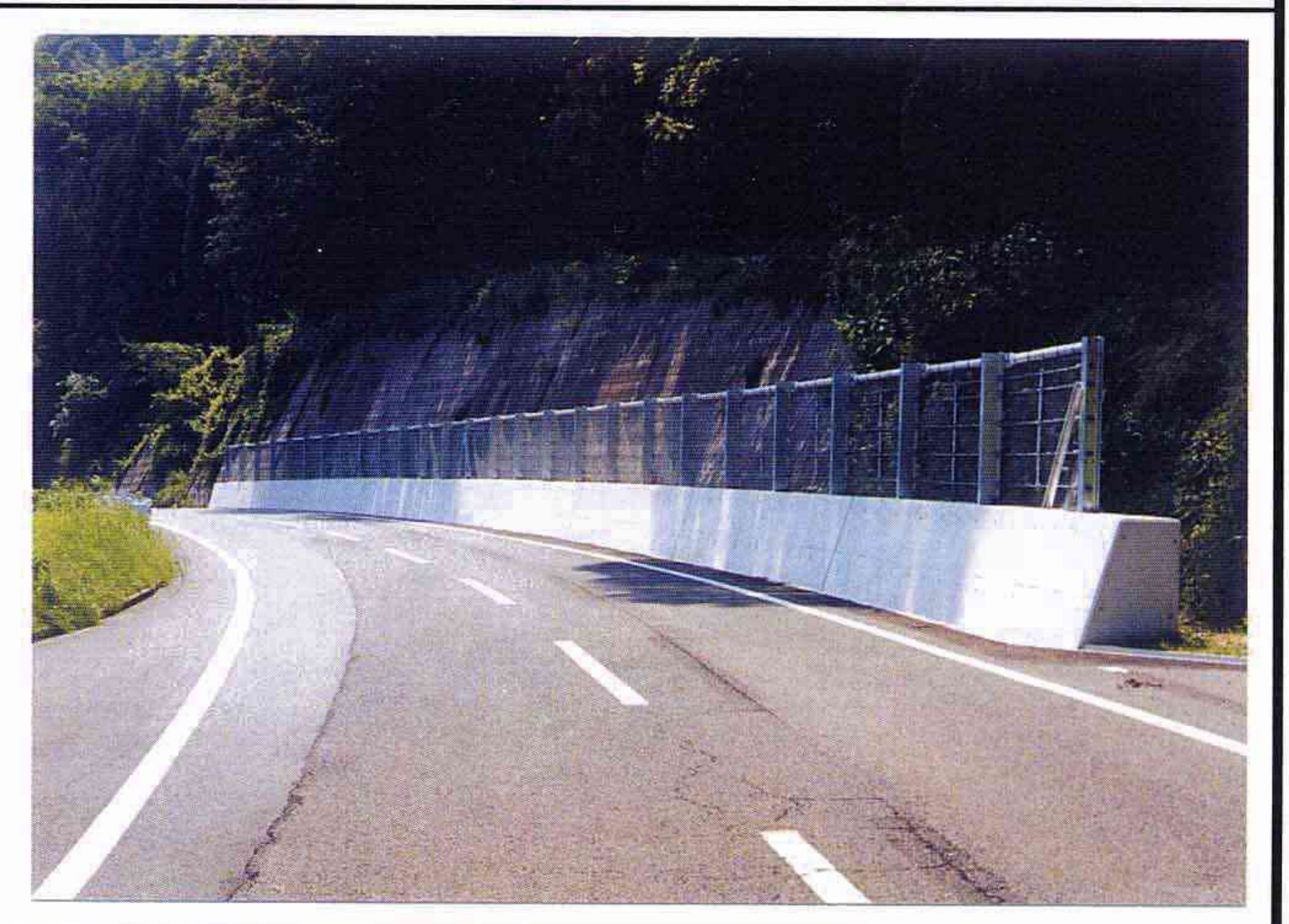
復旧状況写真
