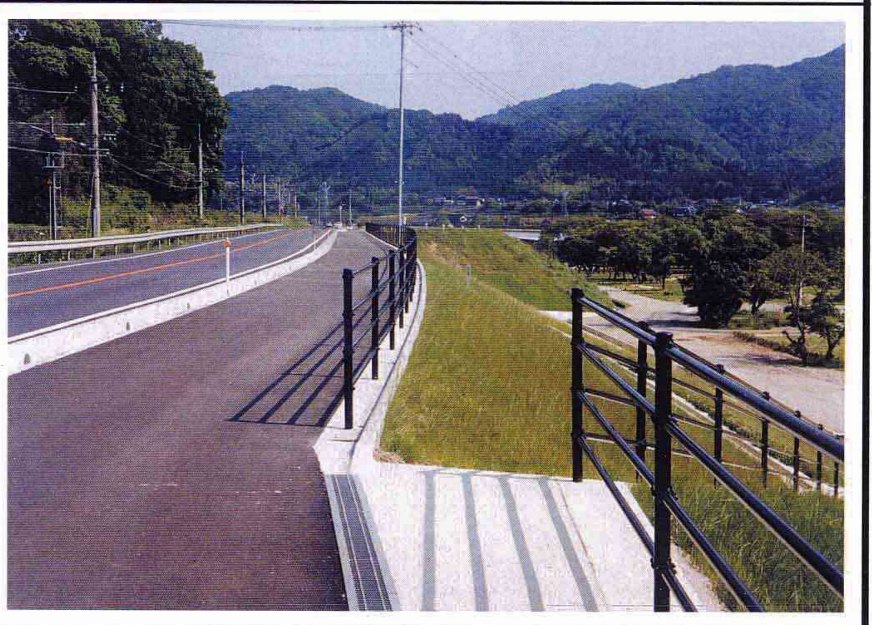
復旧状況写真
