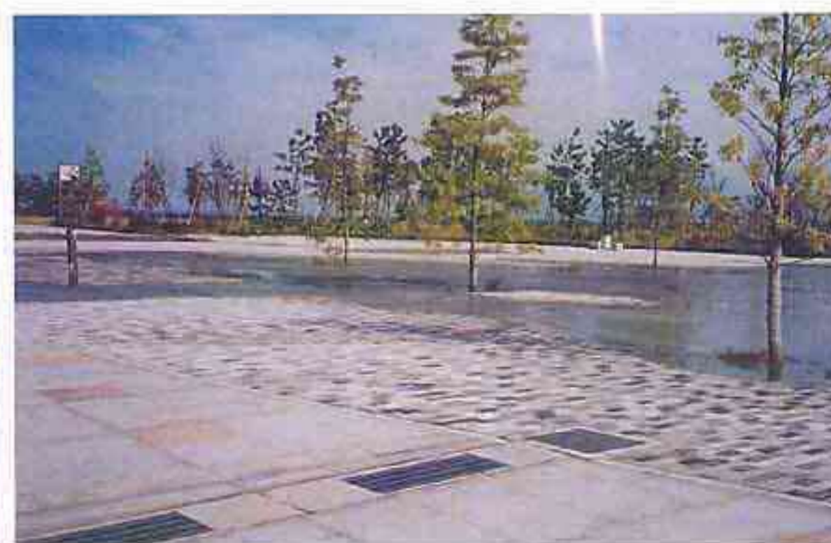
夢みなと公園（広場の液状化）
