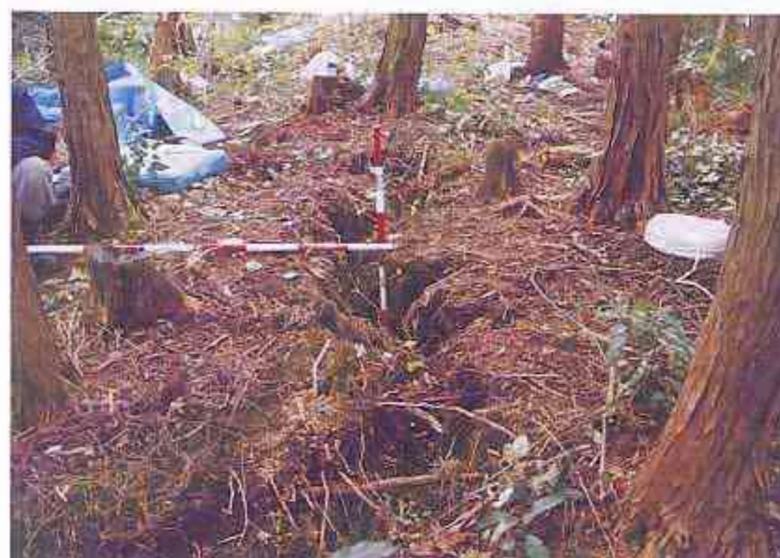
断裂亀裂の延長上に発生した開口亀裂
