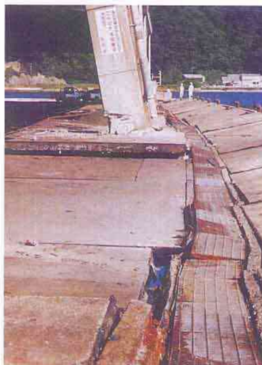
約120m湾曲したかにかご岸壁
