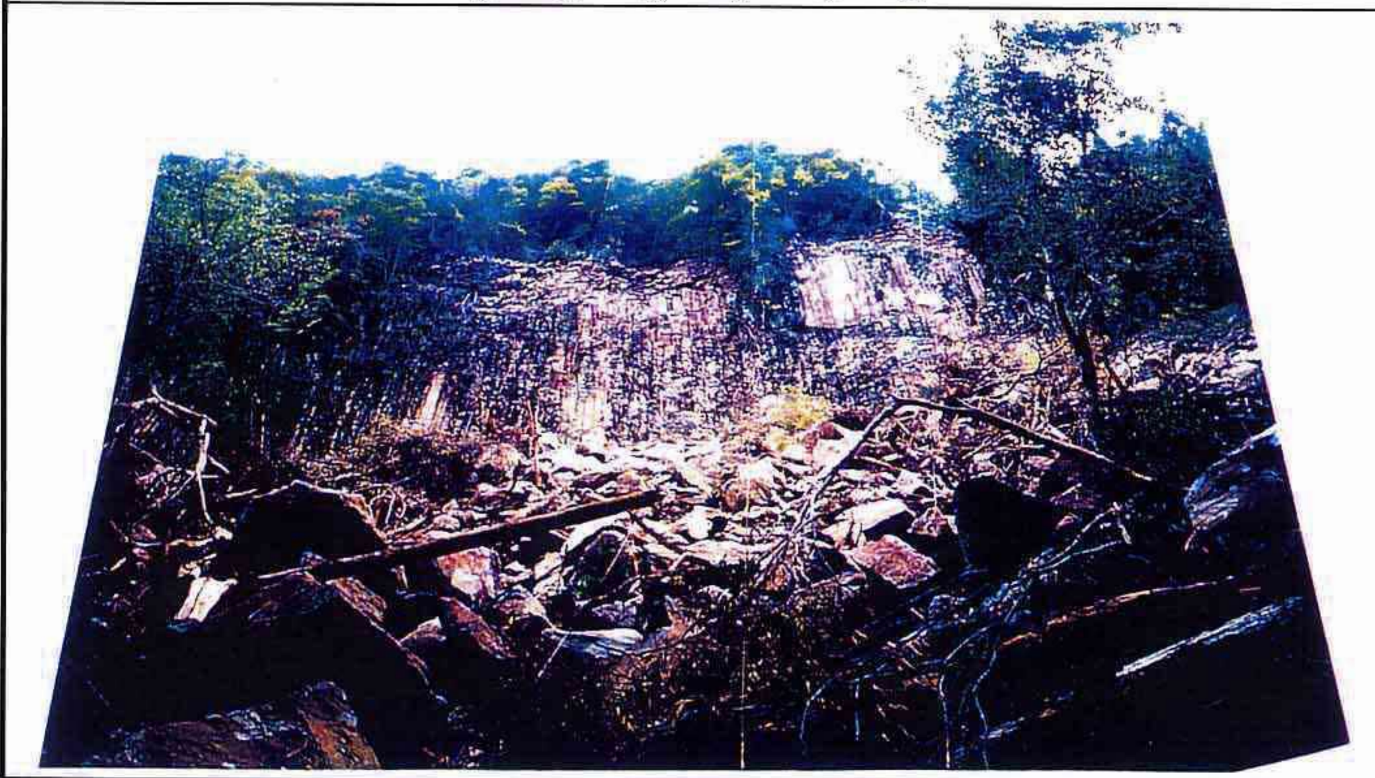
被災状況写真
