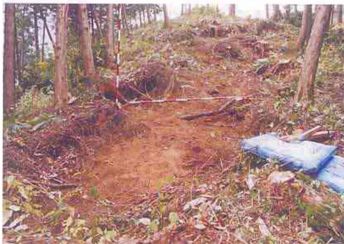
痩せ尾根沿いに発生した断裂亀裂
