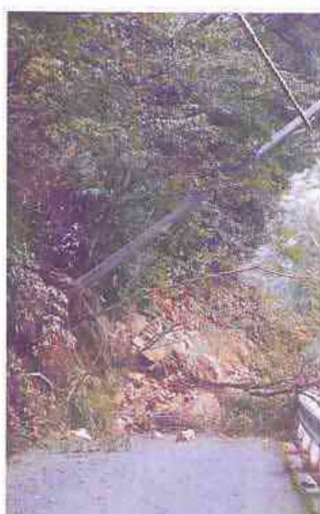
大規模な山腹崩壊により全面通行止めとなった県道
