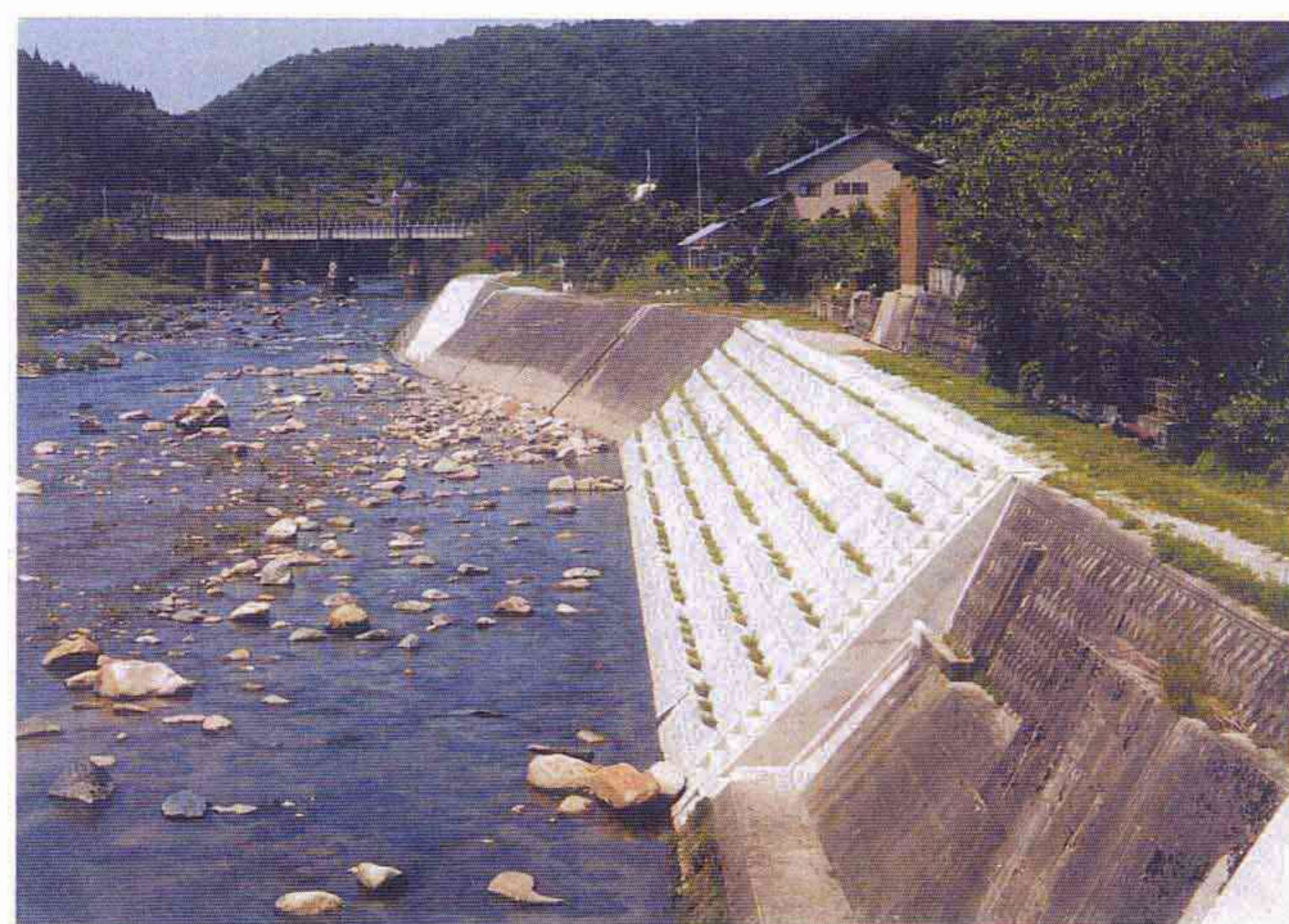
復 旧 状 況 写 真
