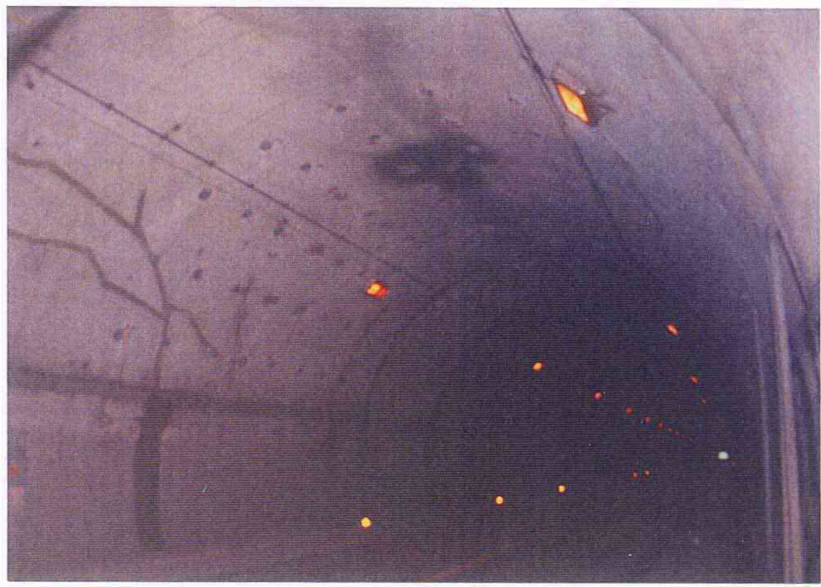
復旧状況写真
