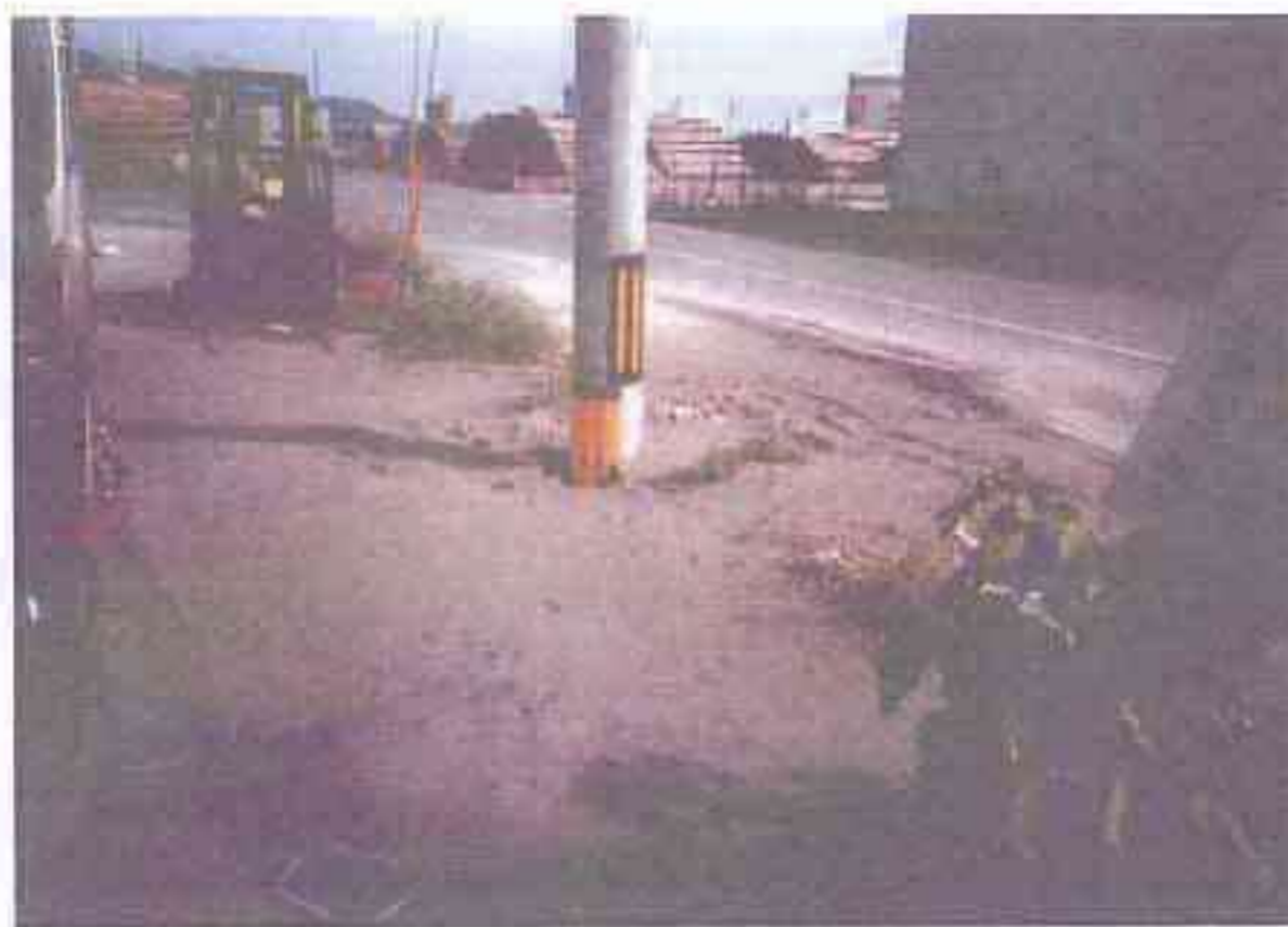
電柱回りの噴砂と電柱の沈下
