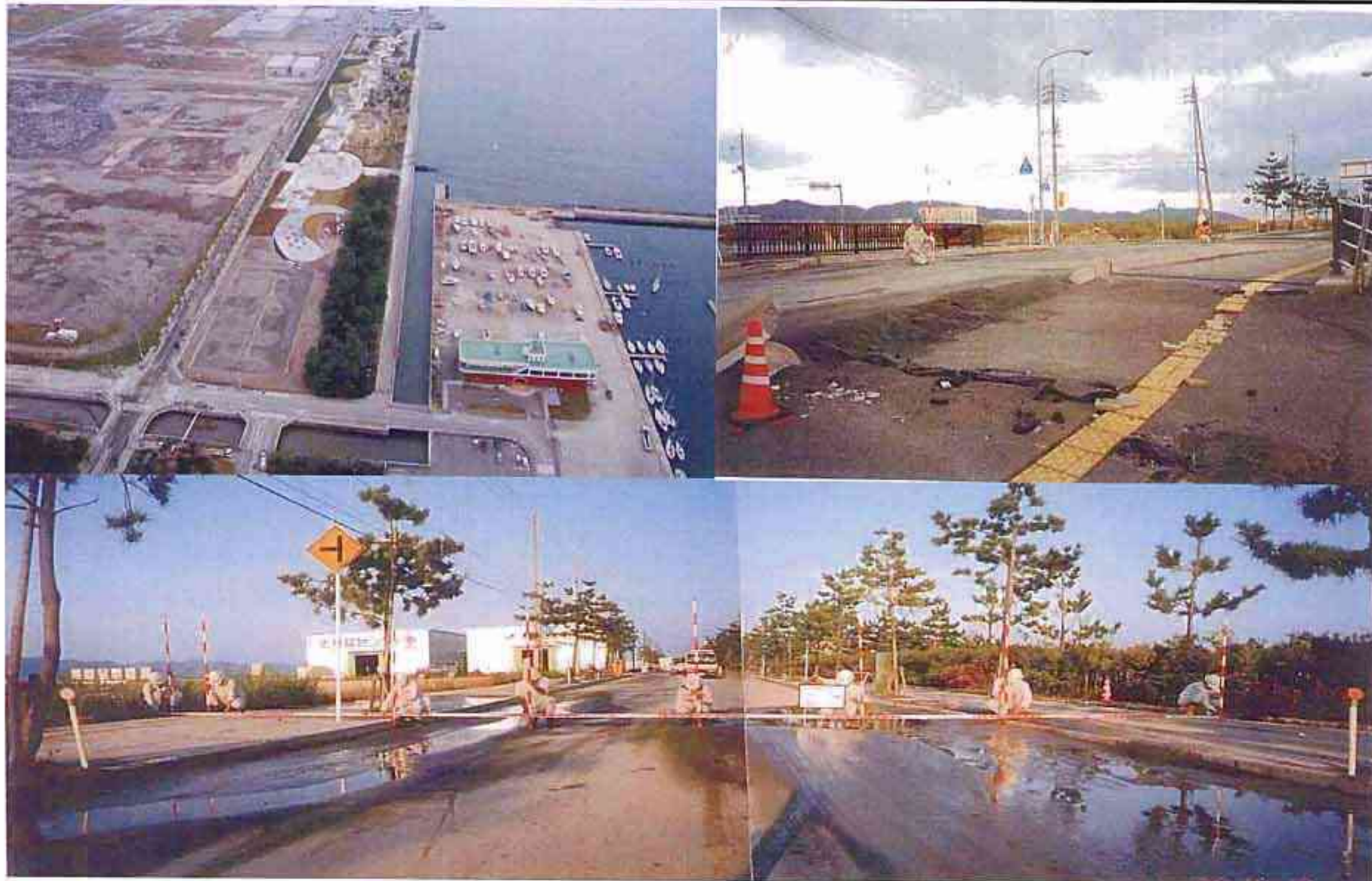
被災状況写真
