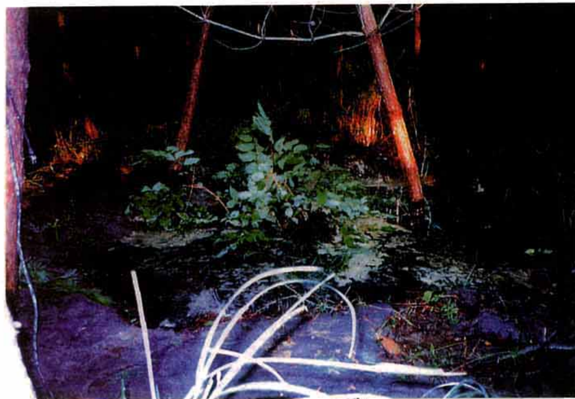
漏水による陥没
