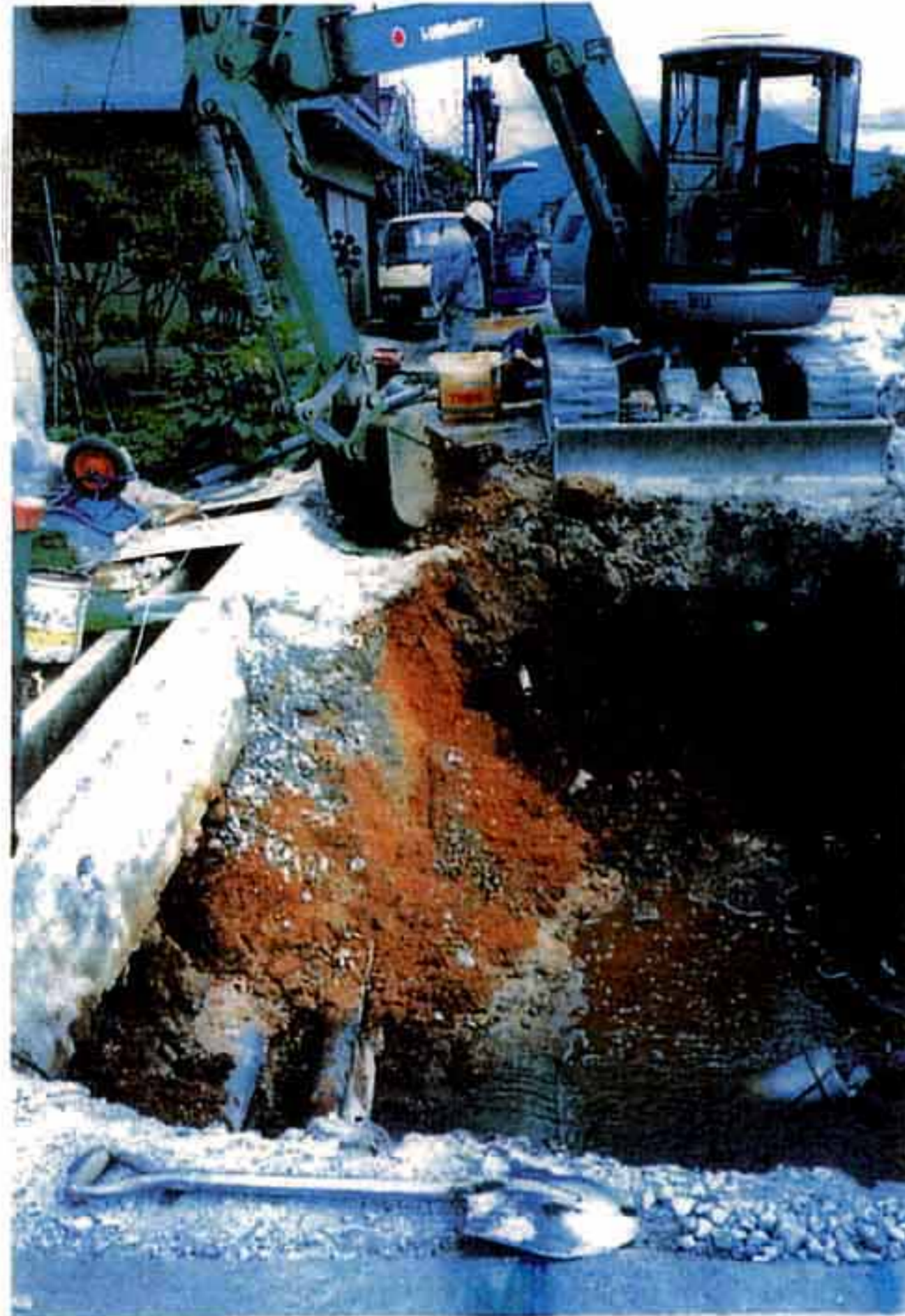
漏水復旧状況
