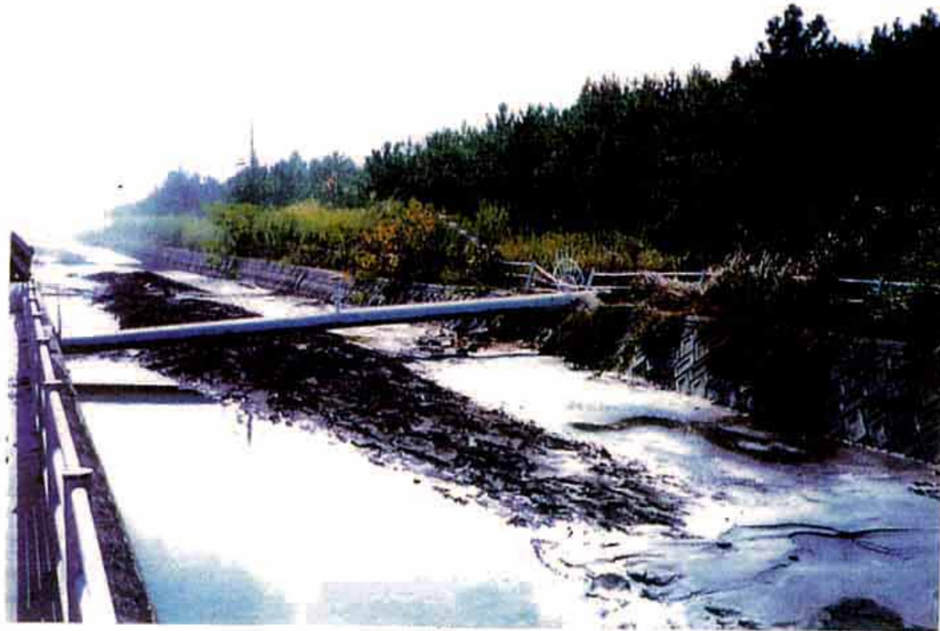
水管橋復旧後
