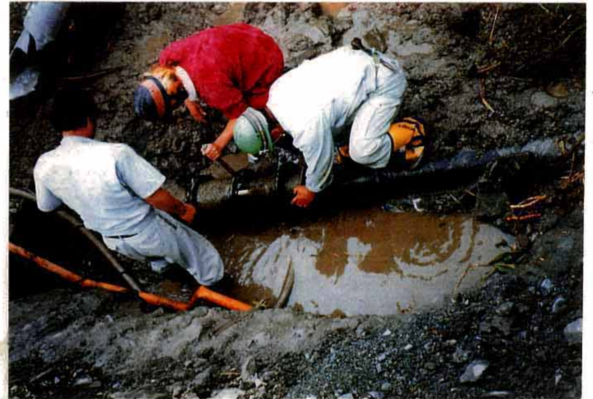
漏水箇所復旧状況 (竹内団地6号線ライン)
