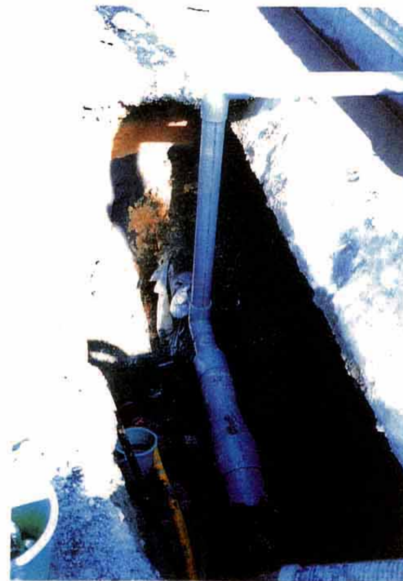
竹内団地 6 号線ライン 仮設配管 (VP-100) (1)
