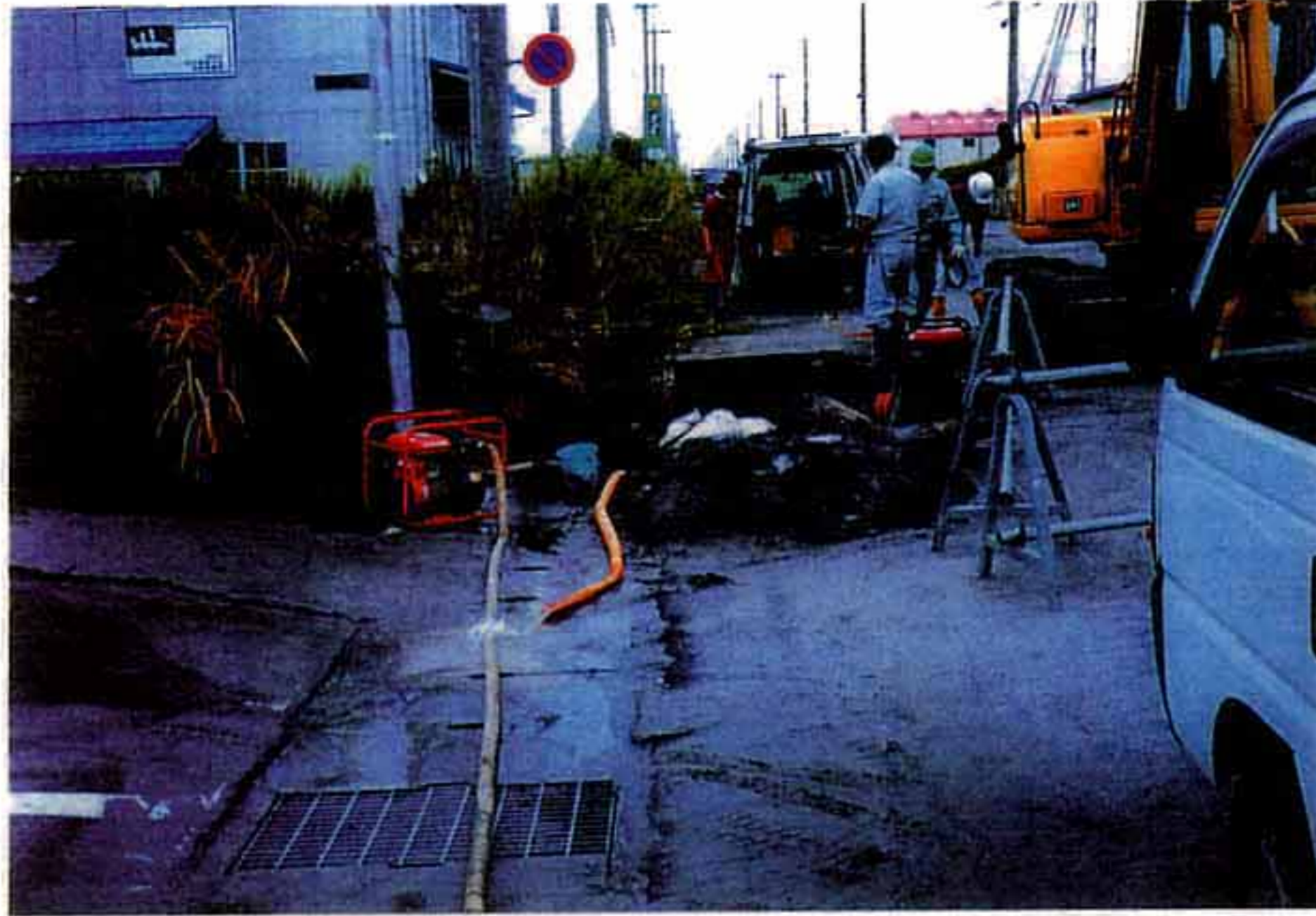
竹内団地 6 号線ライン 止水栓取付 (径 200mm)
