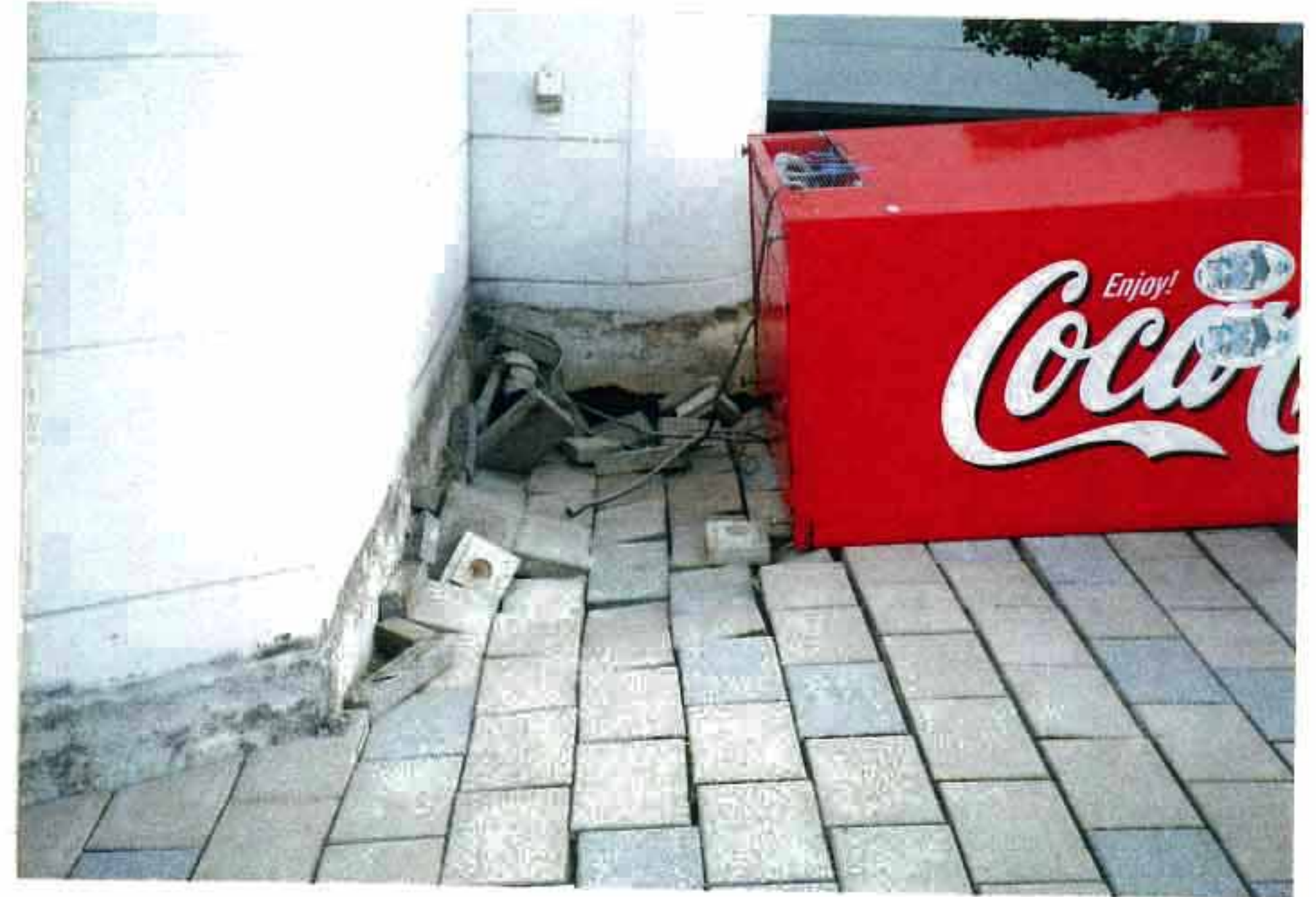
みなと温泉館 玄関付近
