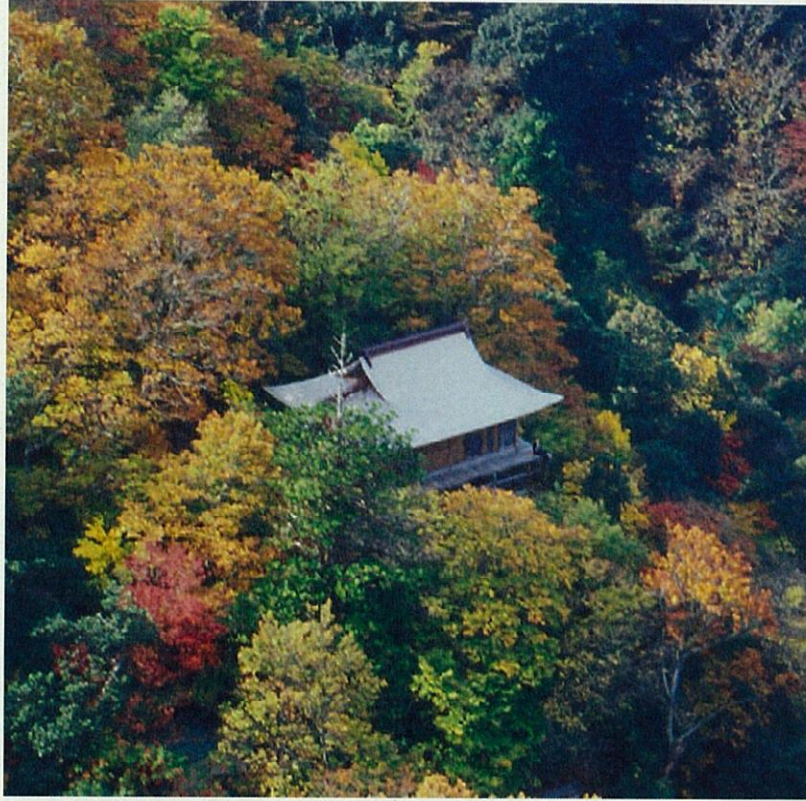
I 三徳地区 4 重要文化財三仏寺地蔵堂
