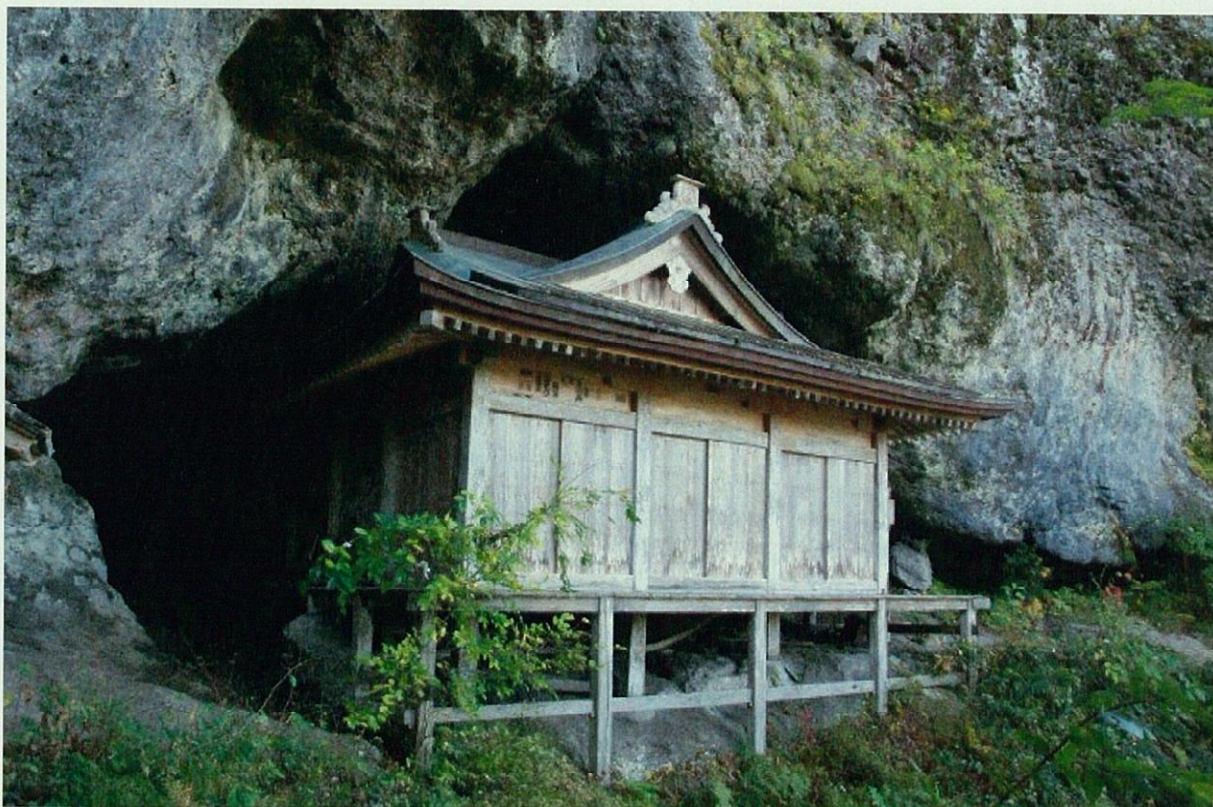
I 三徳地区 8 県保護文化財三徳山三仏寺建造物群(観音堂)
