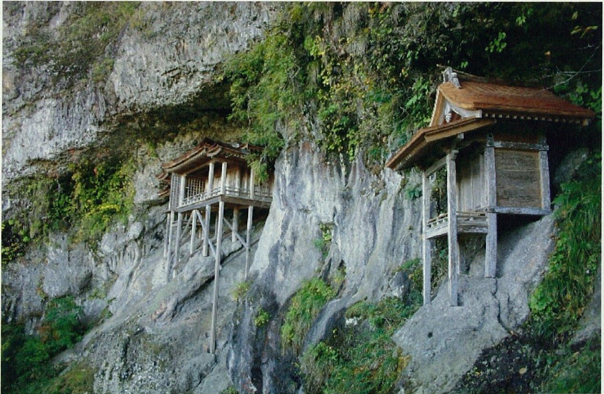
I 三徳地区 1 国宝三仏寺奥院投入堂と、6 県保護文化財三徳山三仏寺建造物群(不動堂)
