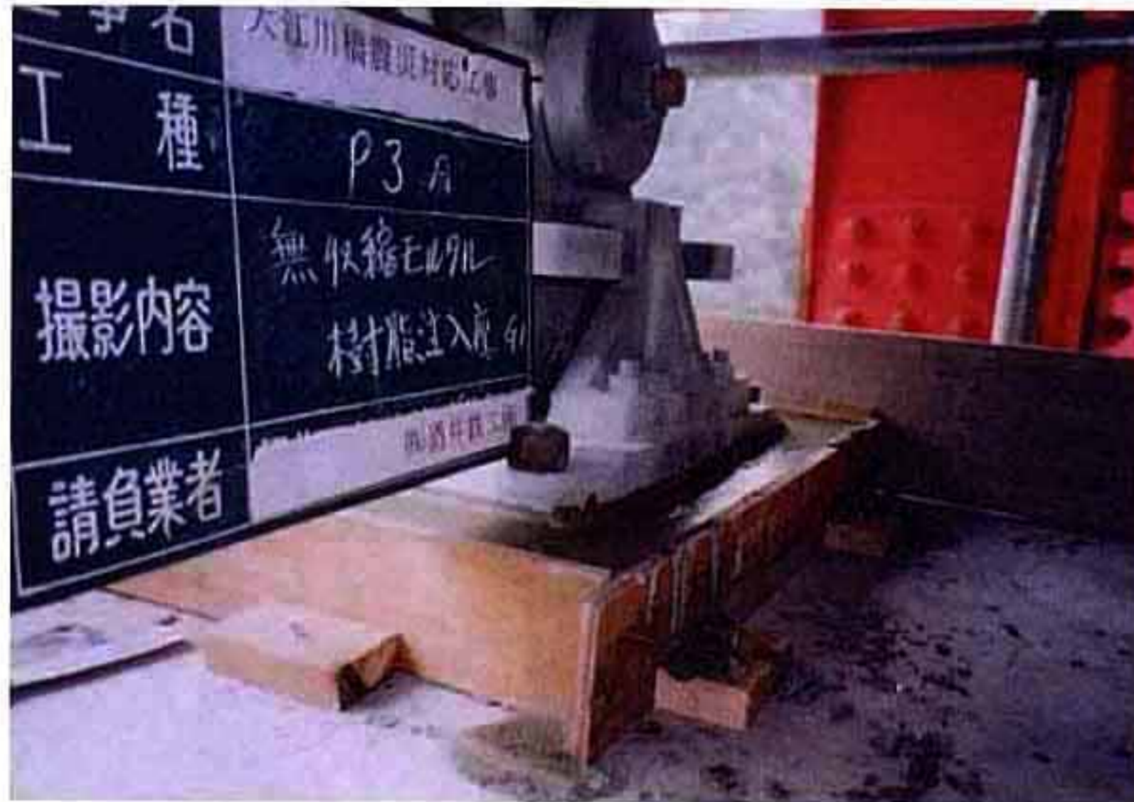
大江川橋 沓座モルタル補修
