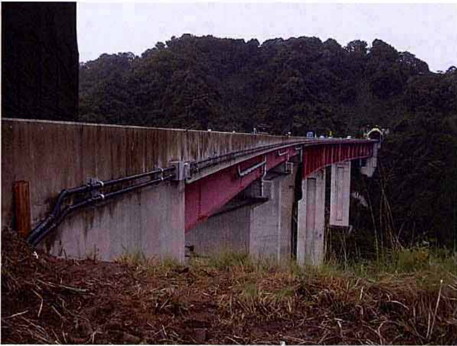
米子自動車道 大江川橋 通信ケーブル復旧情報
