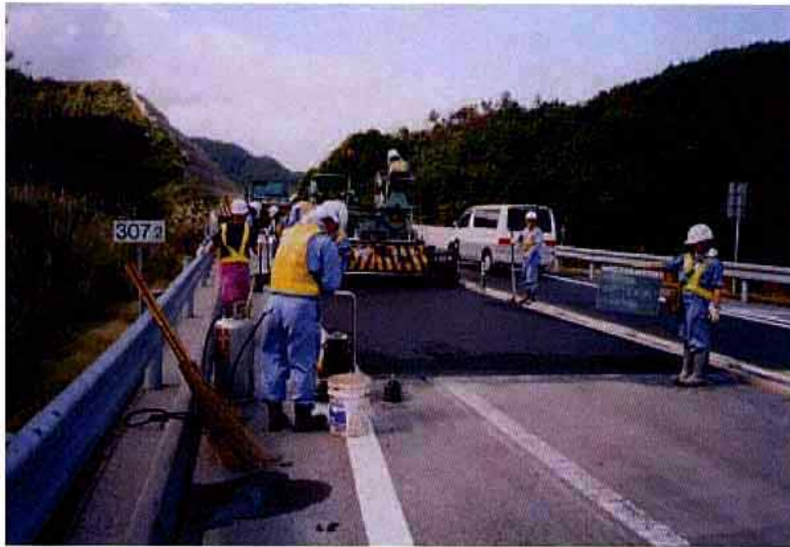
安来道路 段差修正
