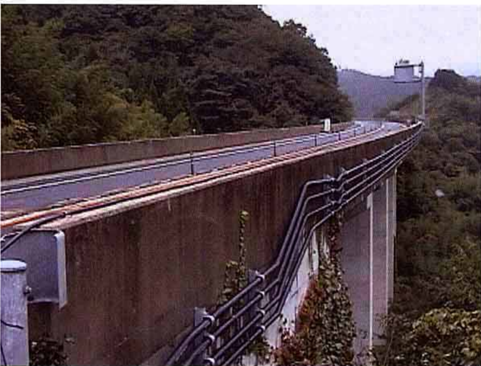
佐川橋 通信ケーブル復旧状況
