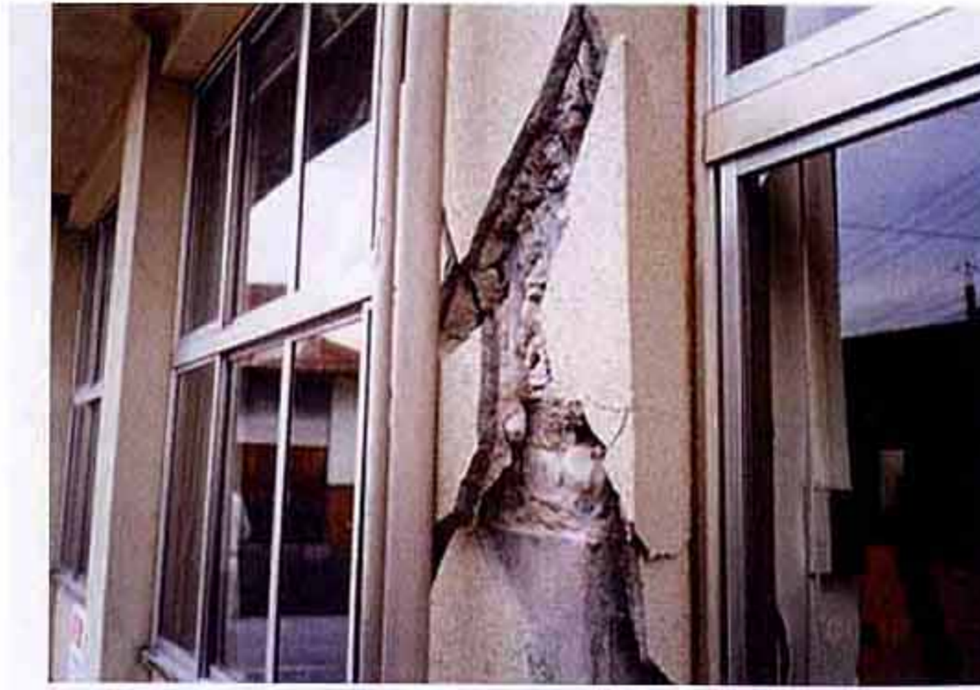
⑬建物外壁の亀裂（溝口町役場） 1)
