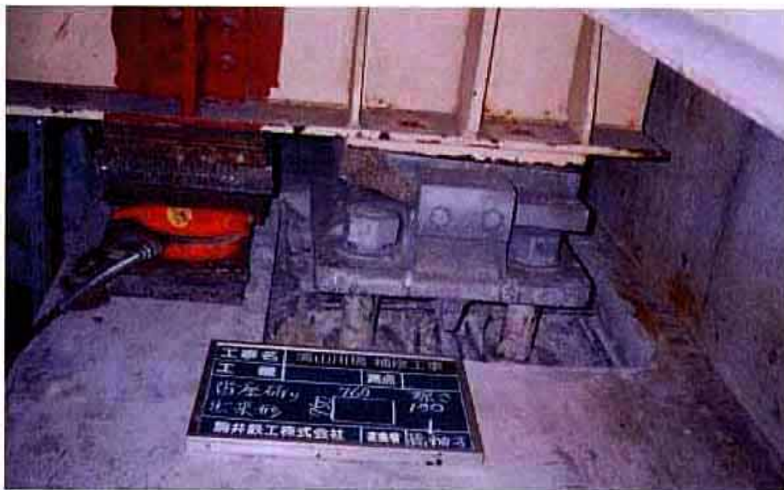
清山川橋 沓座ハツリ完了
