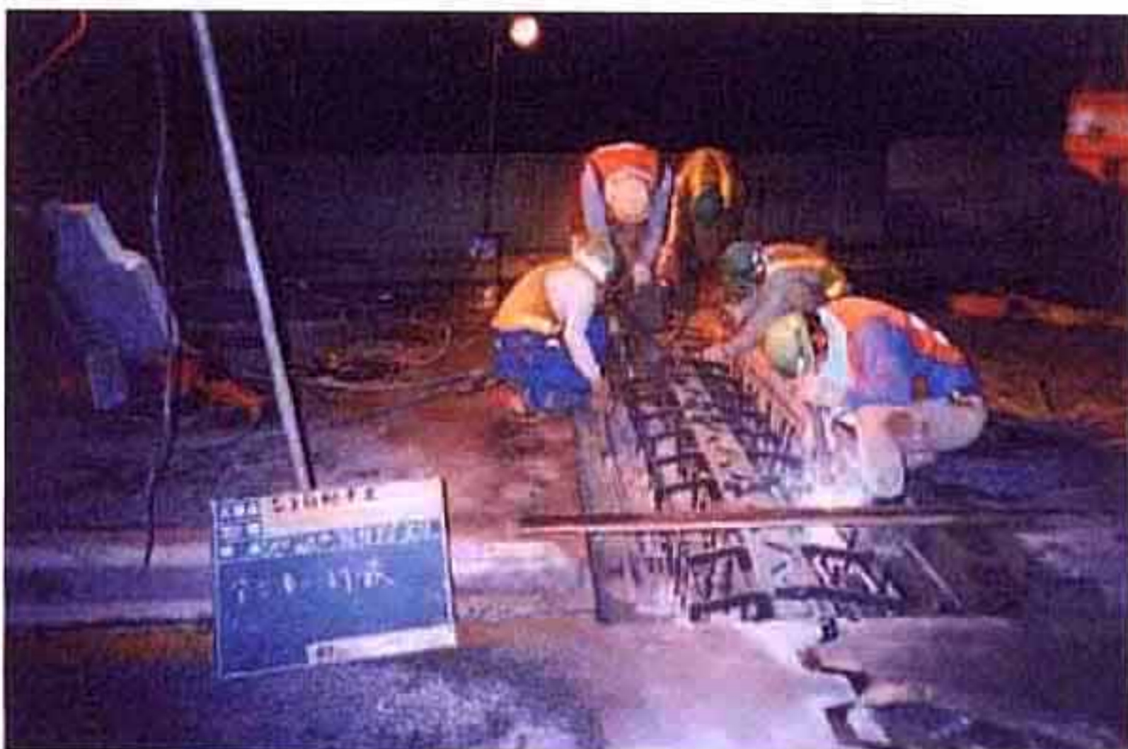
別所川橋 伸縮装置取替
