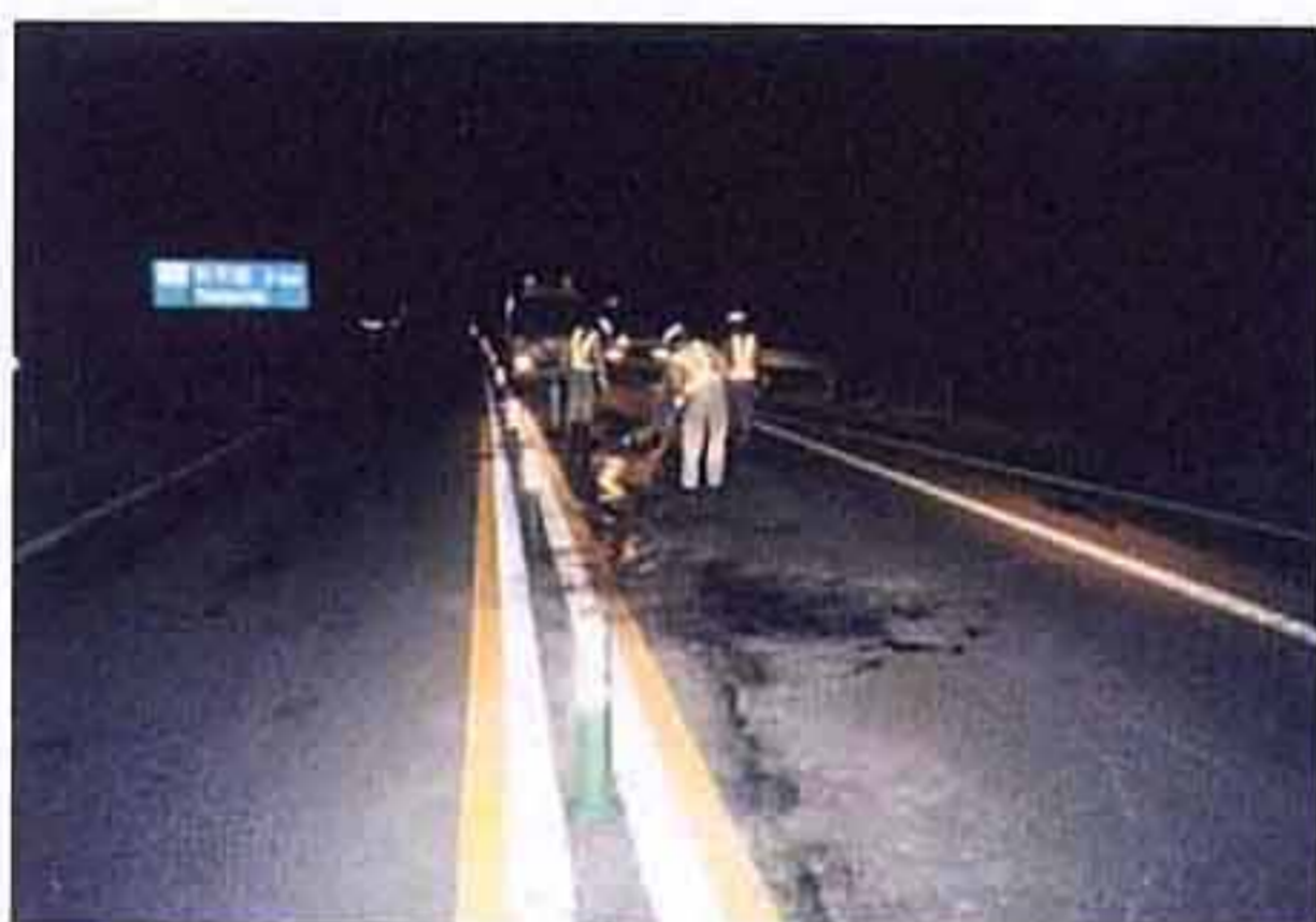
クラック補修
