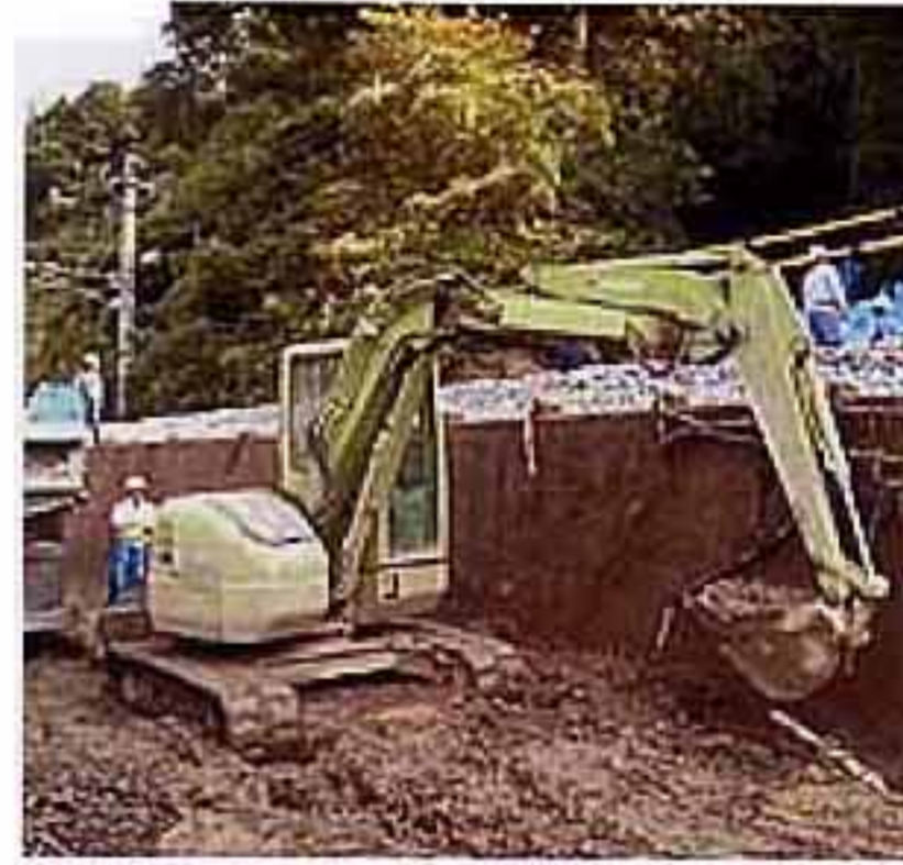
伯備線の復旧作業にあたる作業員
