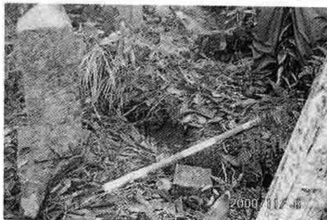
写真-1 上長田神社山門の浮き上がり (鉛直のほぞが抜けていることに注意)
