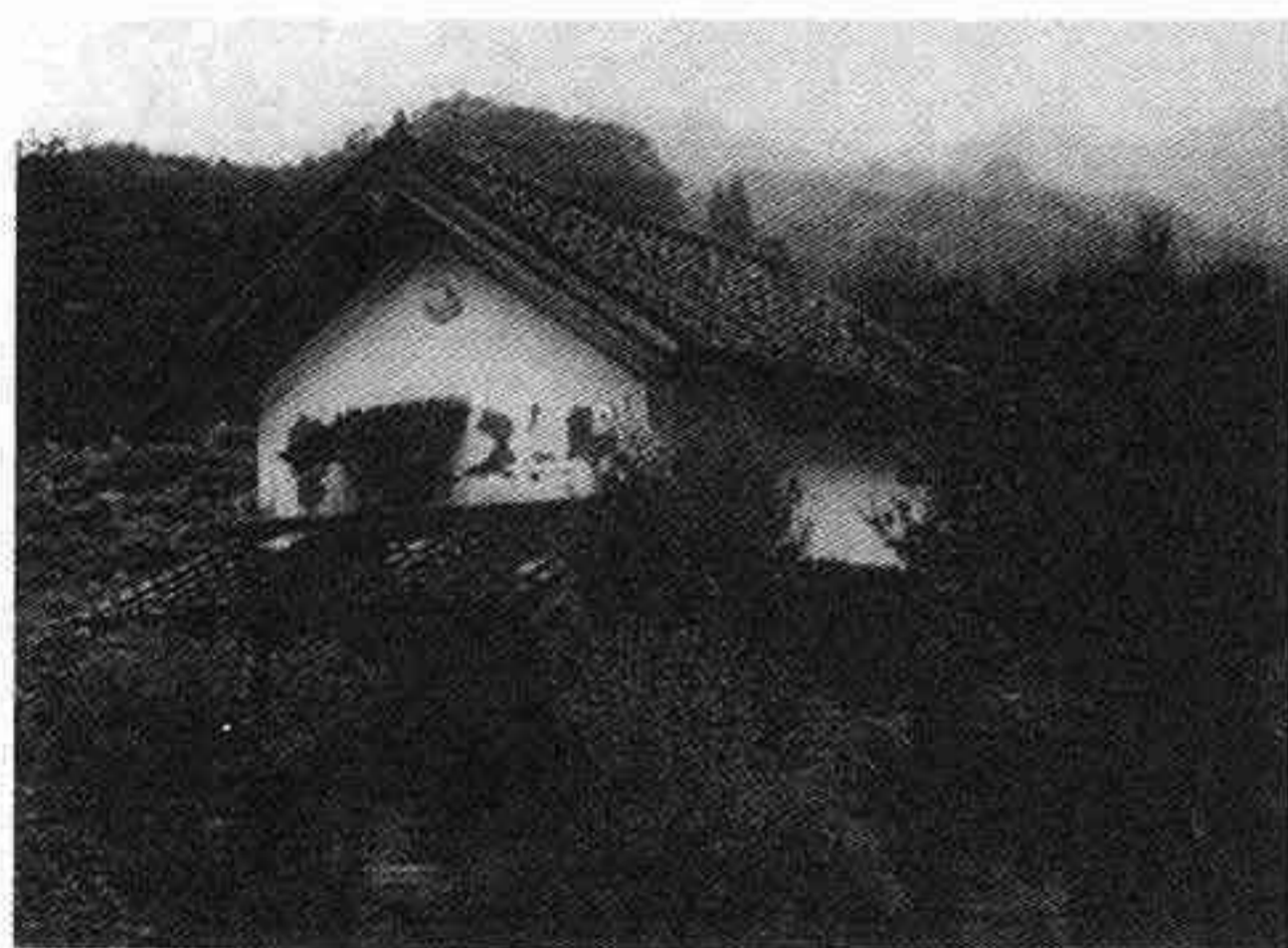
写真-3 土蔵の被害
