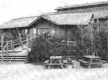
地盤沈下で傾斜したネイチャーセンター
