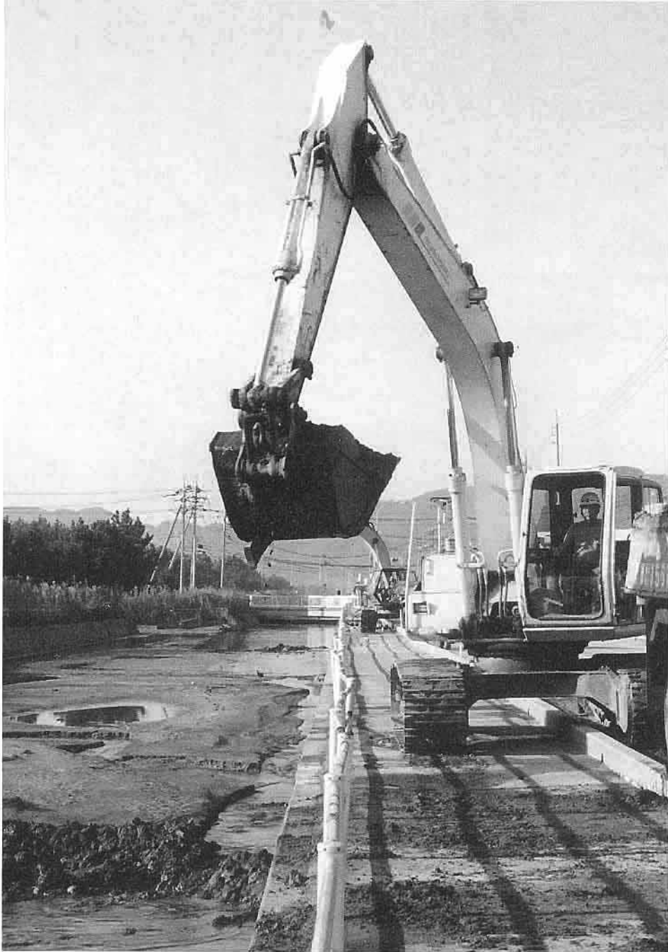
承水路の液状化土砂撤去作業（竹内団地）
