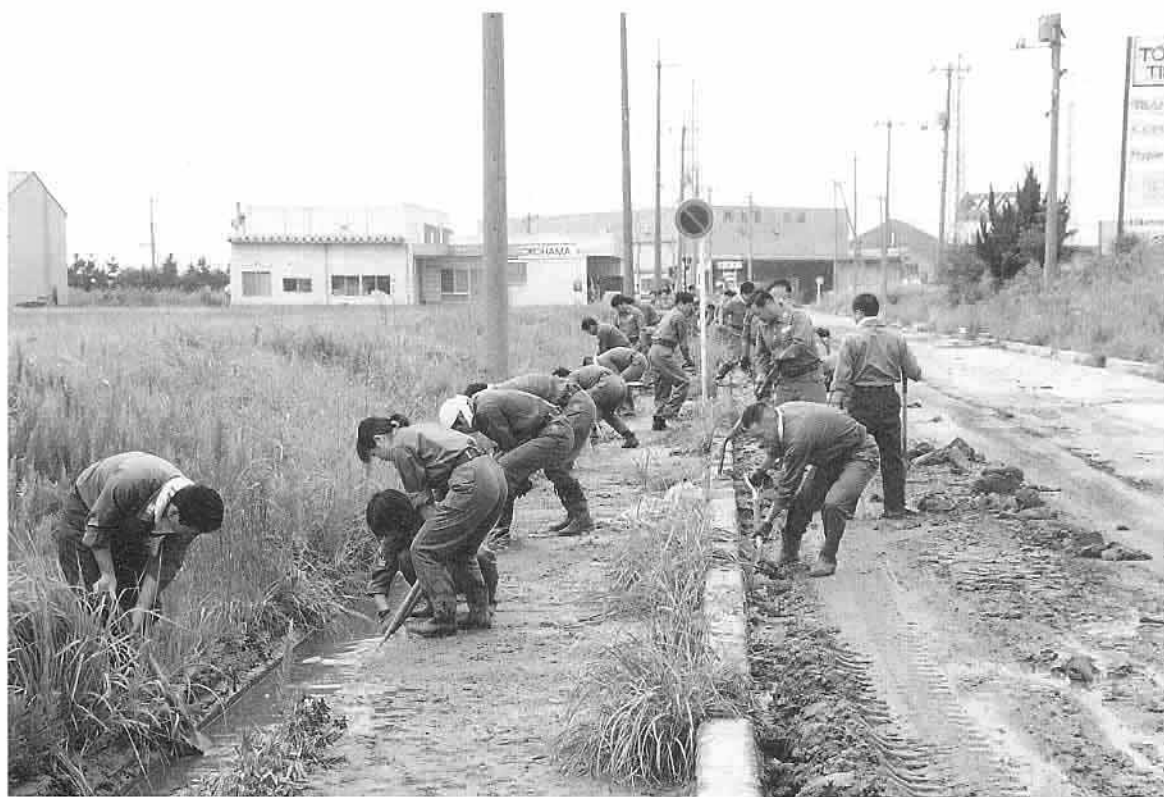
自衛隊による側溝の液状化土砂の撤去作業（竹内団地）
