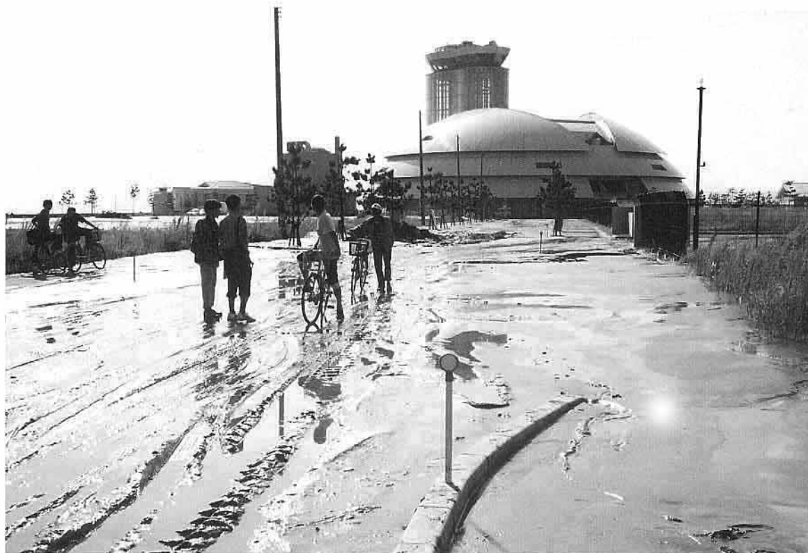
液状化により埋没した道路（竹内団地）
