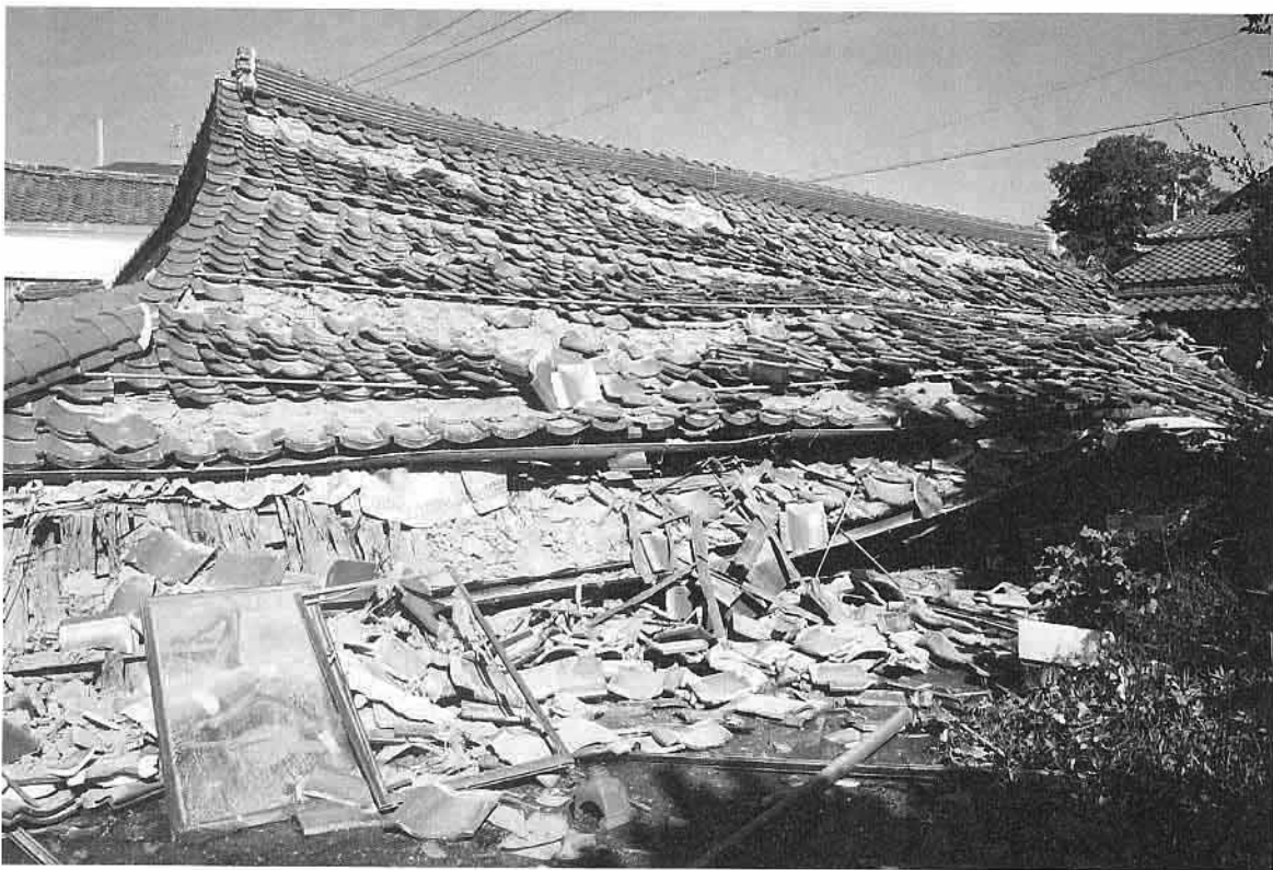
全壊した民家（渡町）
