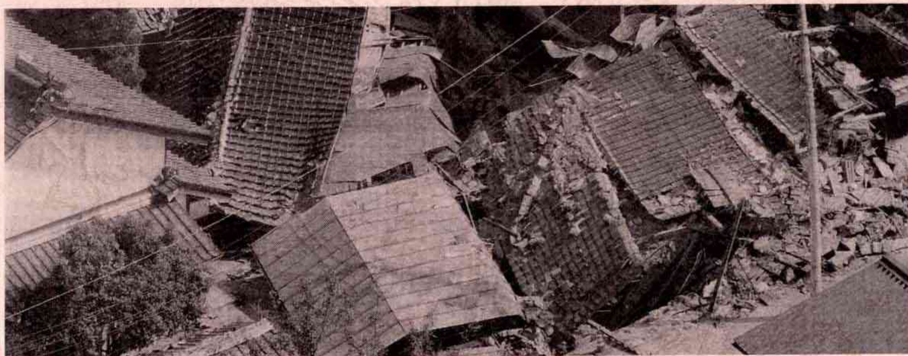
【大きな揺れにより、住宅が倒壊した(阿賀地内) 共同通信社ヘリから 10月8日付 日本海新聞】
