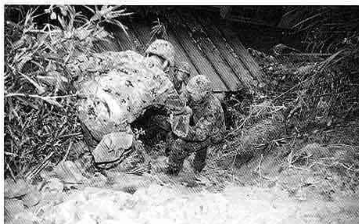
重機の入れない住家裏のがけ崩れを二次災害に留意しながら落石撤去中の自衛隊員
