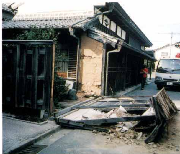
米子市内町の後藤家土塀倒壊
