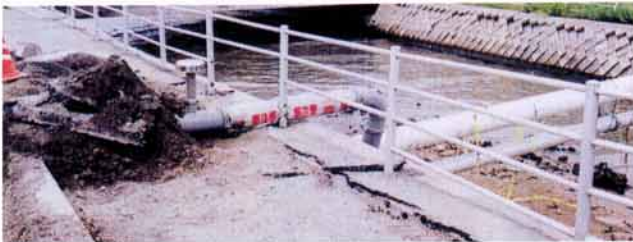
上水道の被害
