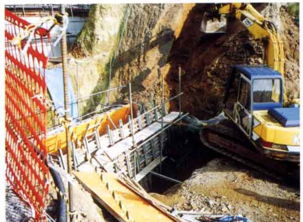
砂防ダム工事現場
