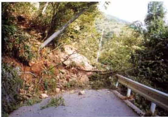
日野町地内主要道の被害
