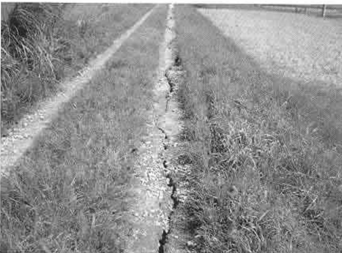
亀裂したあぜ道（吉佐町）
