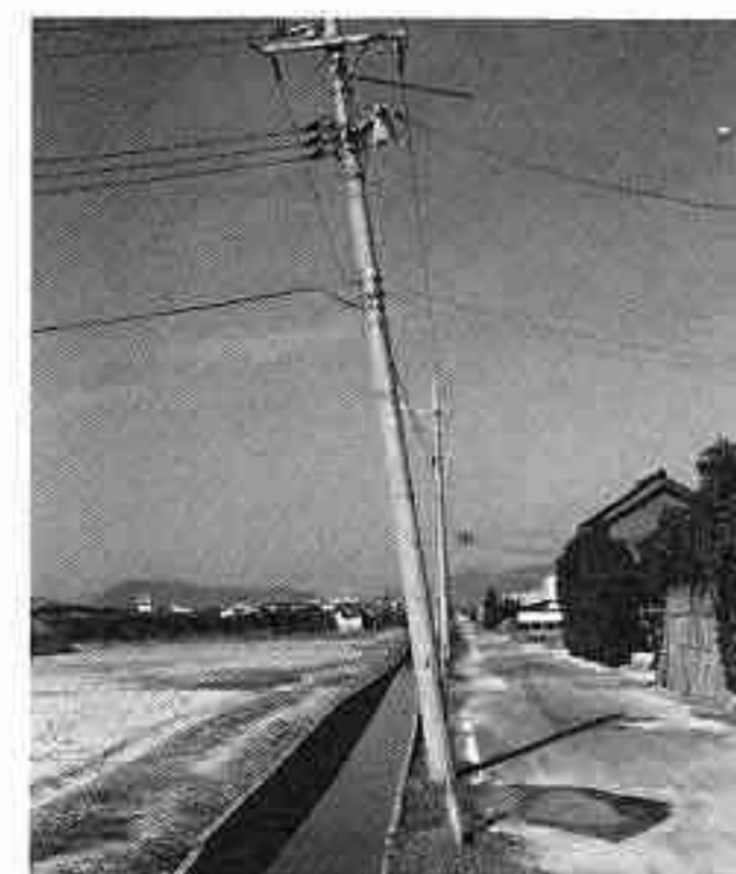
電信柱の傾斜（宮須町）
