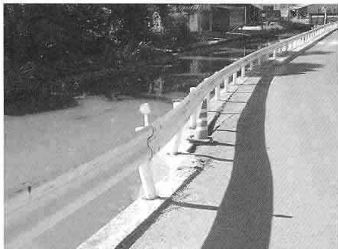
河川道路に入った亀裂（論田町）
