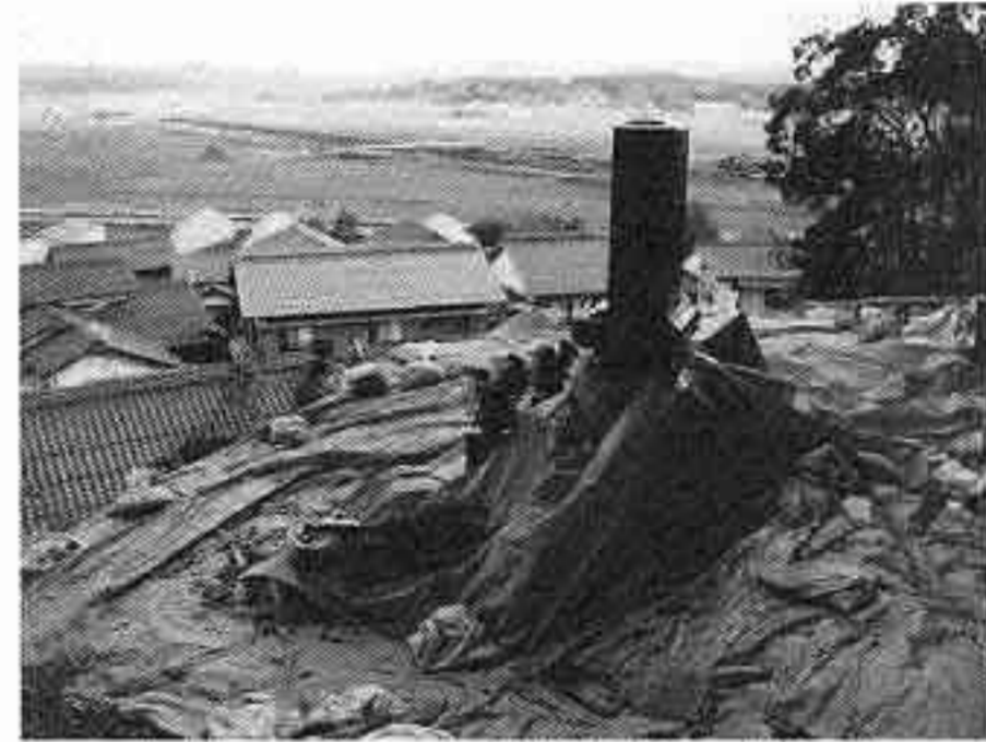
赤崎町現場 立木伐採後の状況
