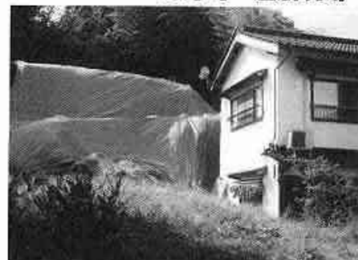
野方町 崖崩現場
