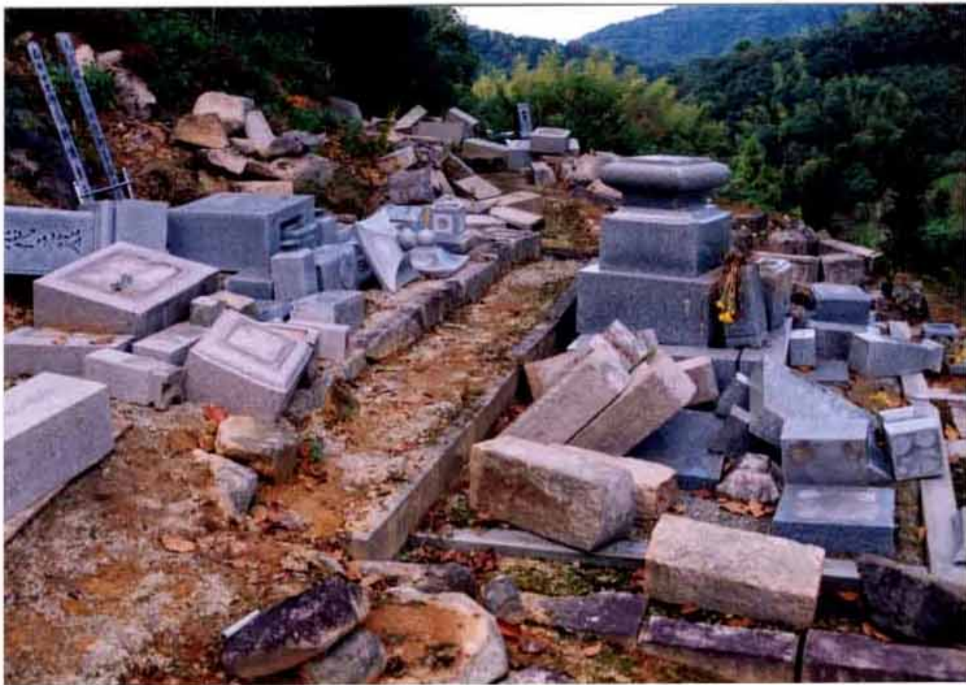
同上 墓石全倒壊状況
