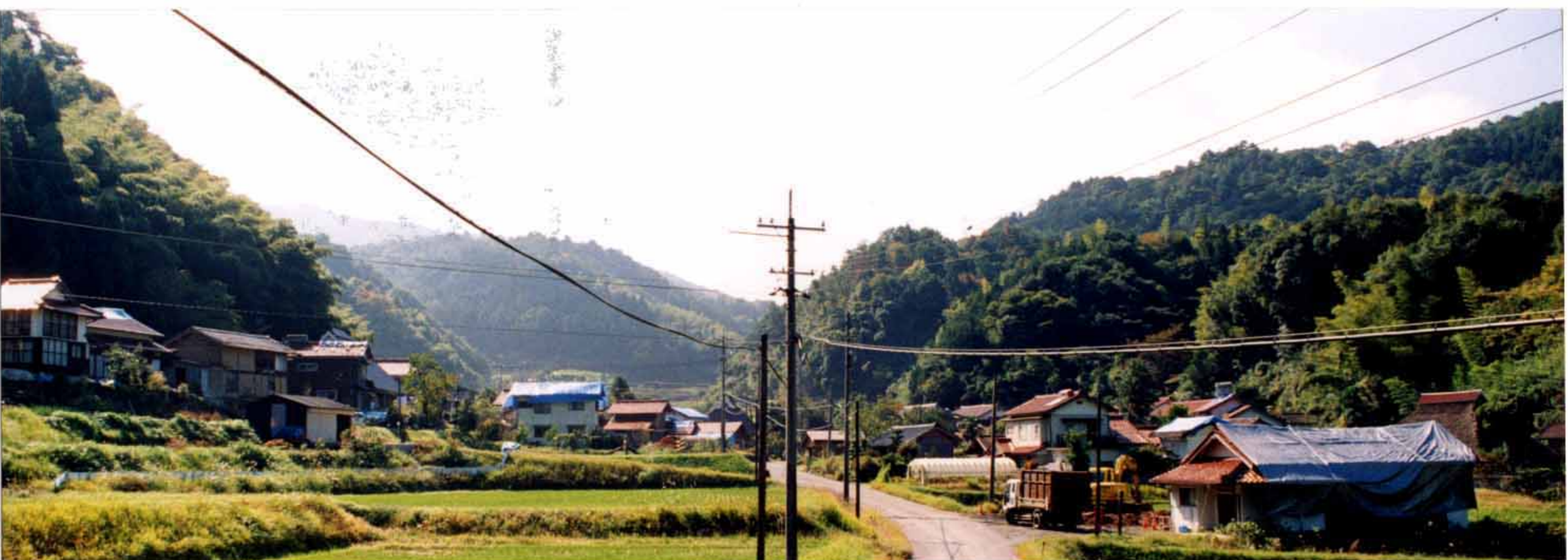
伯太町福留地内 住宅被災状況 (避難所開設地域)
