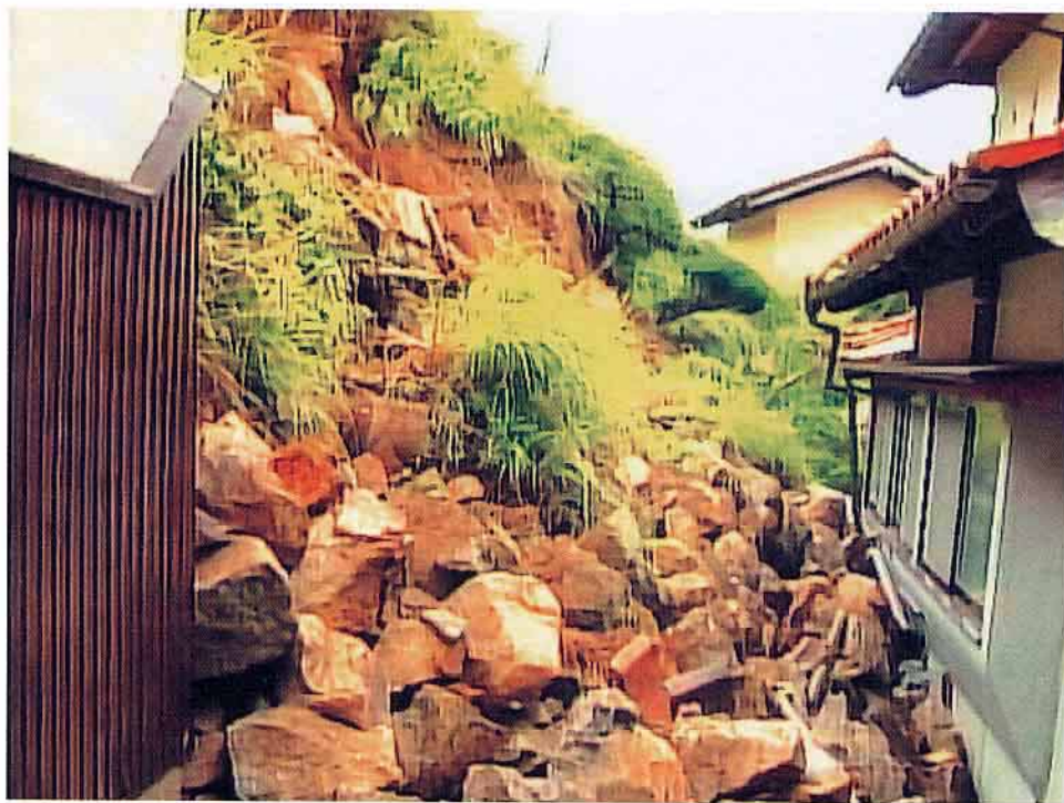
▲大きな石垣が崩れ、住宅を損壊（平成12年10月14日撮影）
