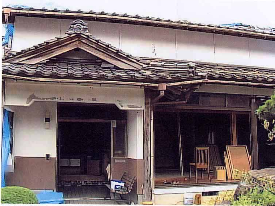
▲家の天井や床は変形して、支柱で支えられ、外壁は剥離している (平成12年10月14日撮影)
