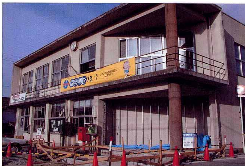
▲被災を受けた役場庁舎（平成12年10月6日撮影）
