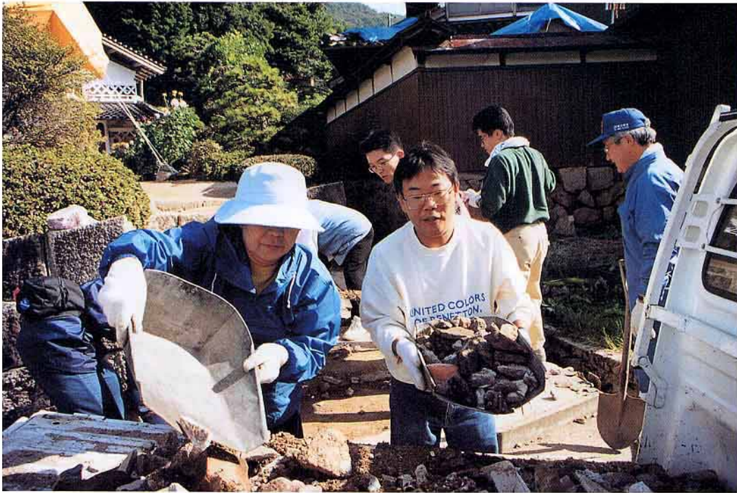
▲ブロック塀のガレキを片付けるボランティア（平成12年10月8日撮影）
