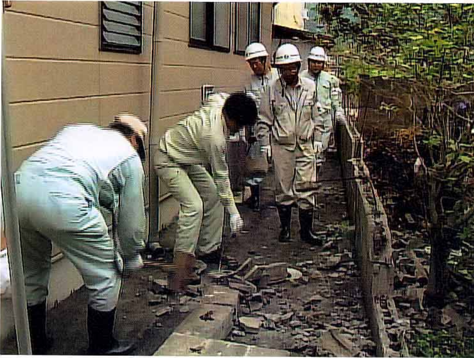
▲ブロック塀のガレキを片付けるボランティア（平成12年10月8日撮影）
