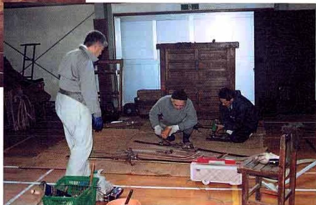
補修作業状況
