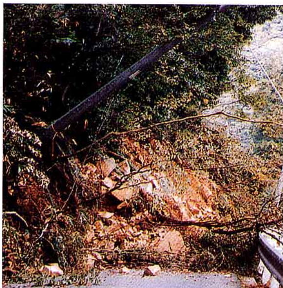
傾斜面崩落による電柱傾斜（日野町）
