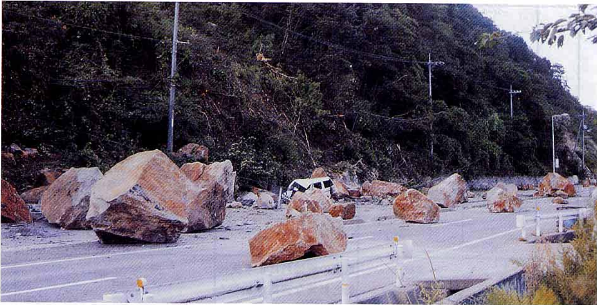
配電線路附近での落石状況（溝口町）
