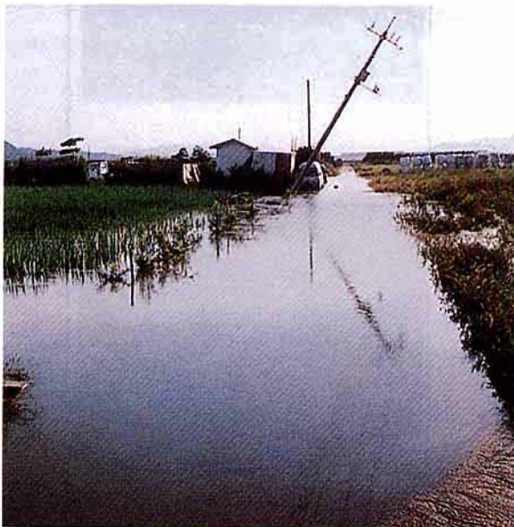
液状化による電柱傾斜（米子市） （米子市河崎 岩原 俊隆氏より提供）
