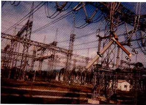
北松江幹線断路器根元から折損（宙吊り状態）
