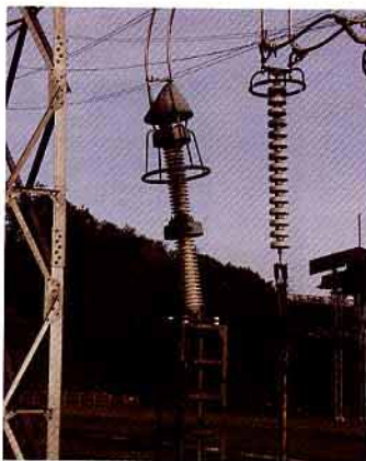
北松江幹線断路器根元から折損（宙吊り状態）
