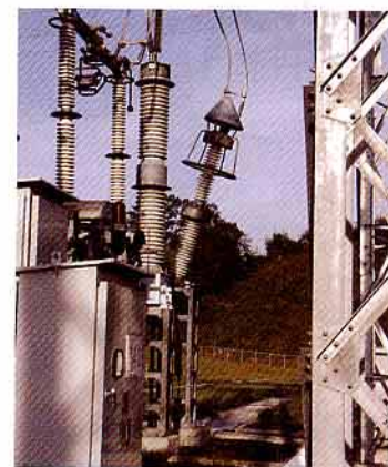
北松江幹線断路器根元から折損（宙吊り状態）
