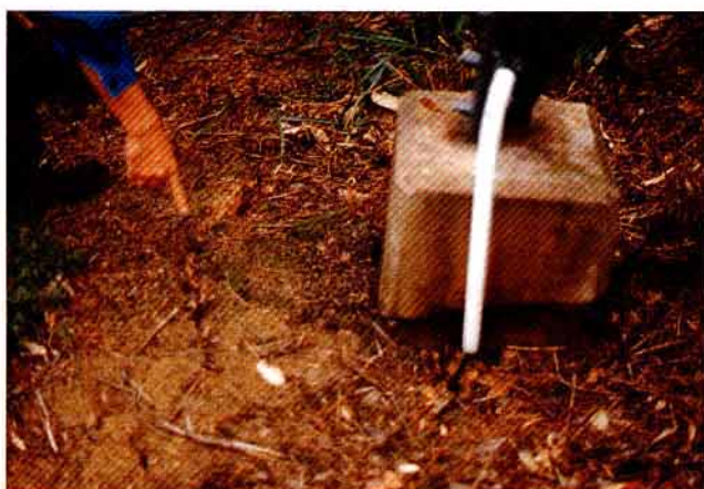
畑池反射板 敷地地割れ状況
