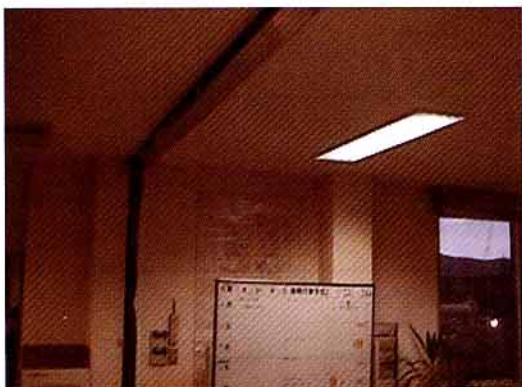
写真8-1 日野(変)制御棟増設接続部分亀裂
