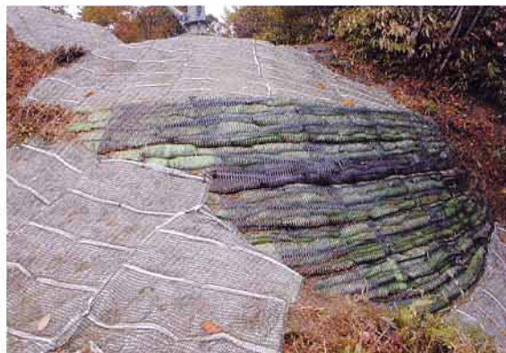
写真2 500kV鉄塔 敷地補修状況2
