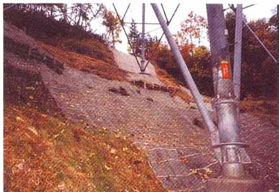
写真1 500kV鉄塔 敷地補修状況1
