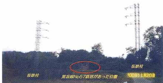
写真3 66kV黒坂線 仮ルート対策状況 (No.57鉄塔)
