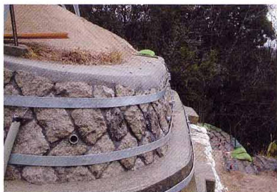
写真5 66kV黒坂線 擁壁修理状況1 (No.50鉄塔)
