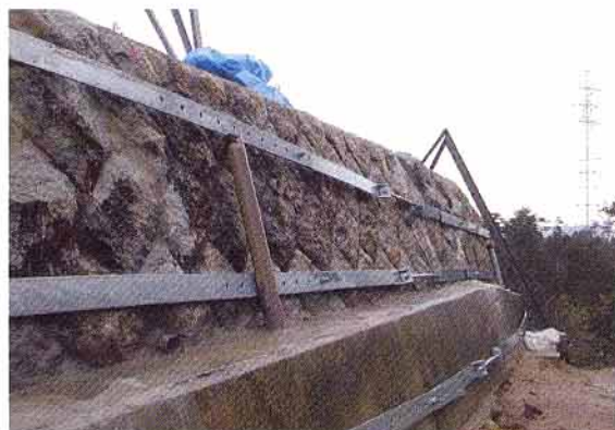
写真6 66kV黒坂線 擁壁修理状況2 (No.50鉄塔)
