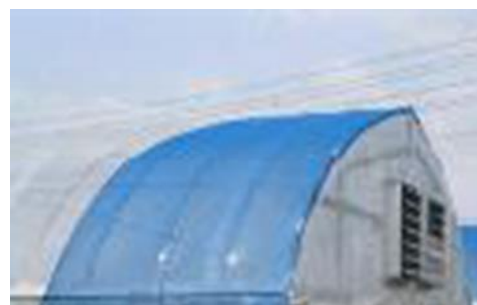
図25 妻面の防風ネットによる補強
