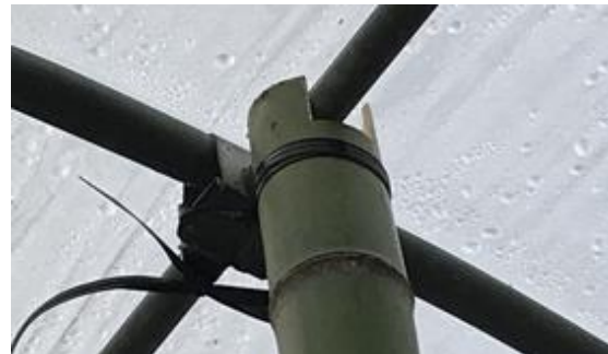
図14 中柱先端の加工と固定
