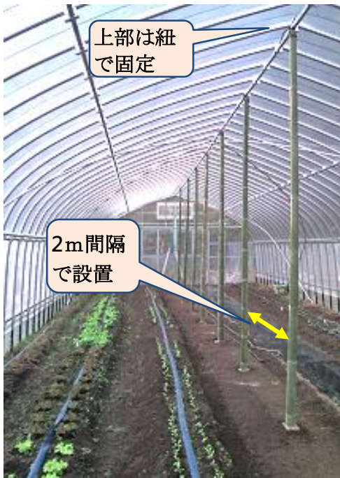
図12 中柱の設置例
