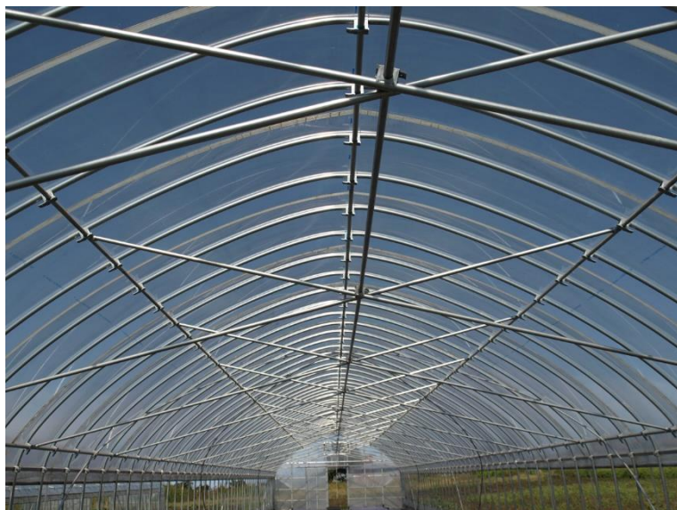
図8 Xタイバーによる補強の事例
