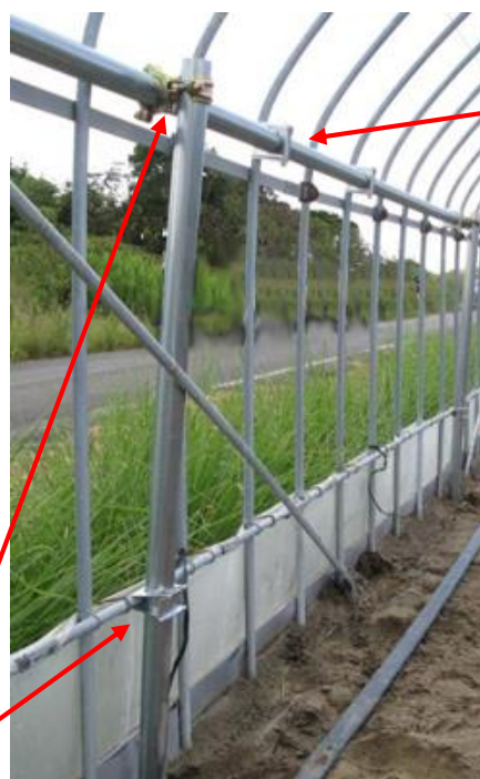
図21 単管パイプによる補強 (静岡県原図を一部改変)
