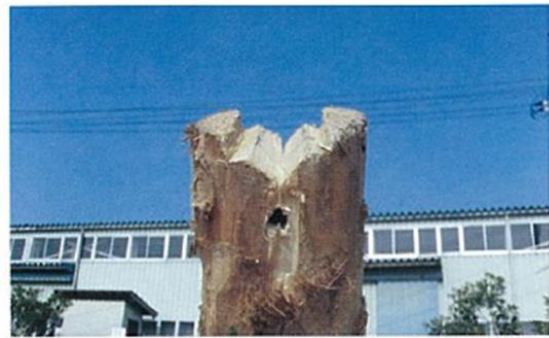
図13 中柱先端の加工
