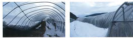
(偏った積雪により骨材が曲ったハウス)
