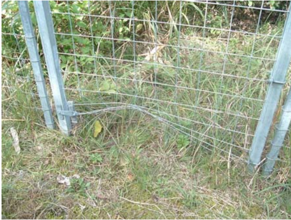
金網柵の下部からの潜り込み (通常、金網はアンカーで地面に固定します。)
