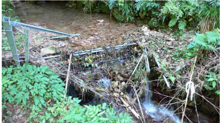
水路での柵の破壊 (計画段階でのルート検討が重要です。)
