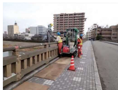
橋梁点検支援ロボットによる点検
