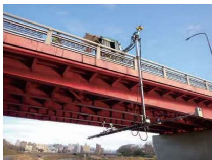
橋梁点検支援ロボットによる点検
