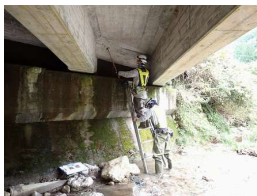
＜ハシゴ等による点検実施状況＞
