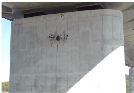
ドローンによる点検
