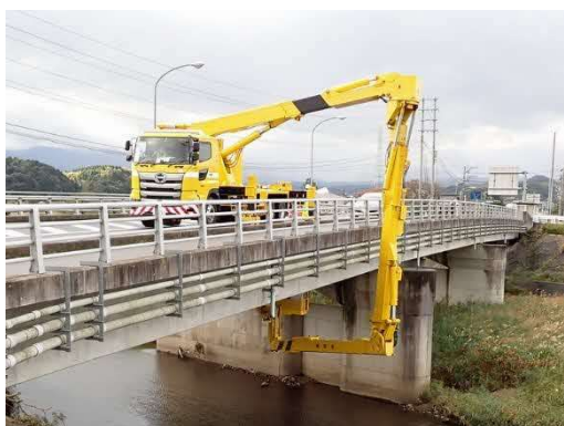
＜橋梁点検車による点検実施状況＞
