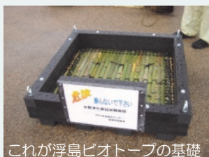
これが浮島ビオトープの基礎
