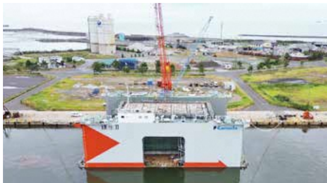
第1防波堤延伸(直轄事業) ケーソン製作状況
