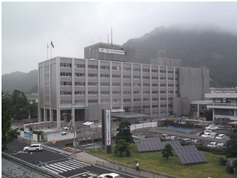
本庁舎（南面より）
