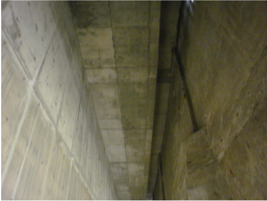
⑤ 免震層型枠脱型狀況
