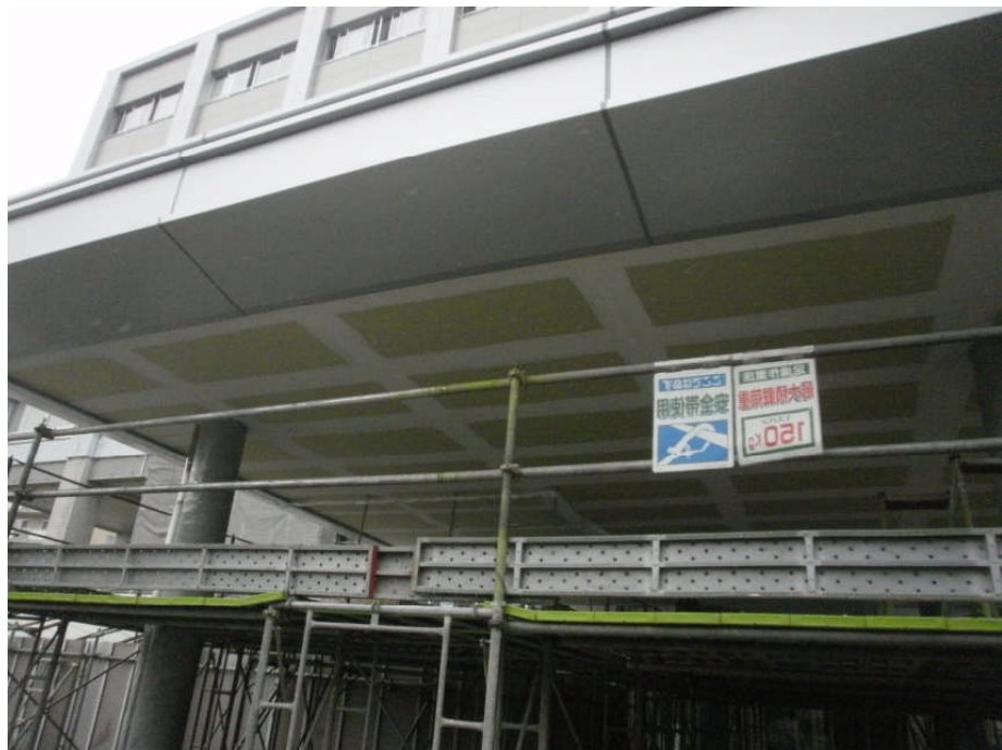
② 南側正面玄関キャノピー
