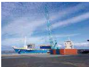
鳥取港でのクローラークレーンによる船積みの様子
