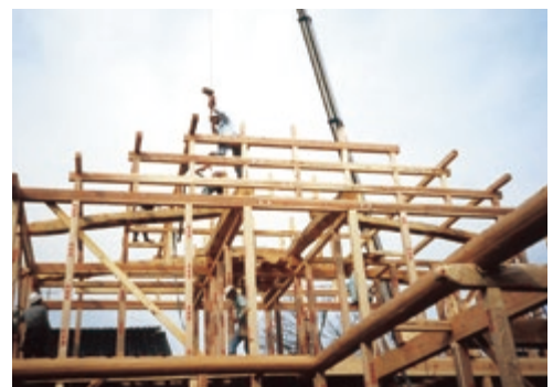
木で家を建てている様子（八頭町）
