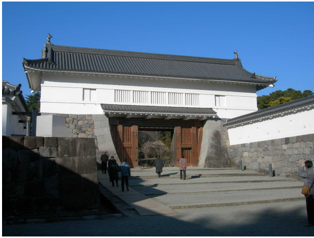
復元された小田原城二ノ丸大手筋「銅門」
