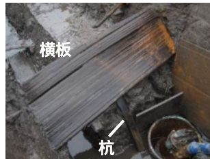
第2段階 横板と杭による護岸
