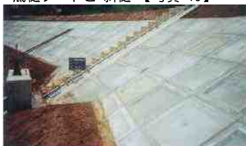
《ゲートの稼働不良や護岸の亀裂等の有無》
