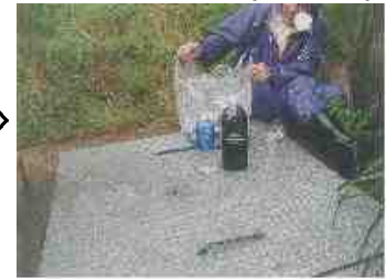
漏水状況確認(墨汁等)
