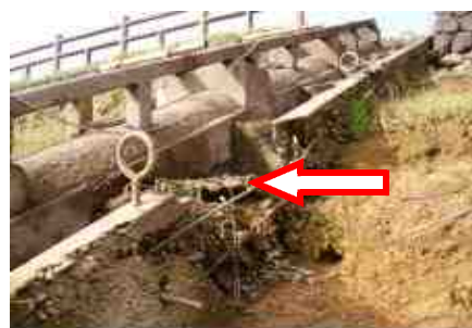
斜樋の破損【写真-5】
