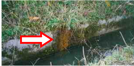
堤体法尻水路付近の漏水状況【写真-1】
