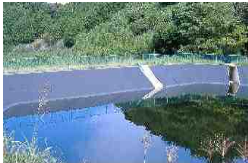
ゴムシート張のため池の施工例【写真-9】
