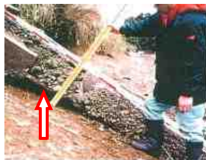
斜樋の破損【写真-5】
