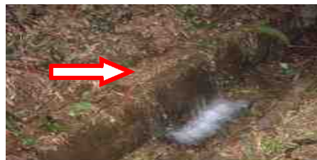
斜樋底部の陥没 【写真-3】
