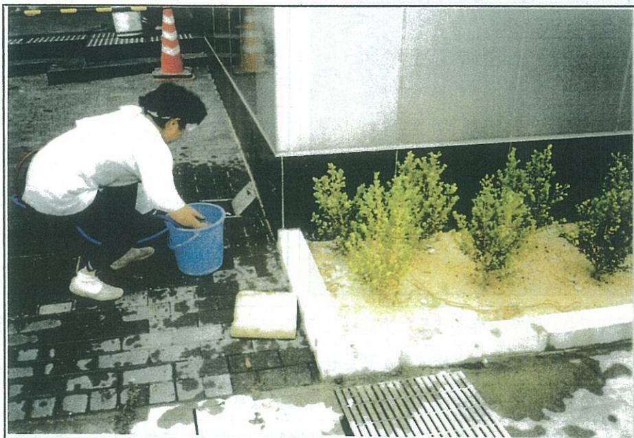
外構インターロッキングは、歩行用のものを使っております。車等の乗り入れをしますと、下地の路盤が下がる可能性があります。重量にも拘りますが、高所作業車などで高層部の清掃等をされるときは、土砂に鉄板などを敷くなどの養生が必要ですので、専門業者に御連絡下さい。
