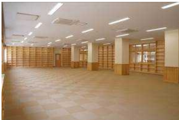
■米子東高等学校(管理教室棟) 壁材と造り付棚に県産材を使用。
