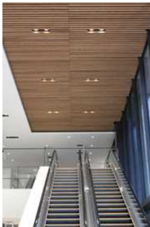
■県立中央病院(エントランスホール) 天井に県産杉を、この他緩和ケアのラウンジの壁にも同材を使用。
