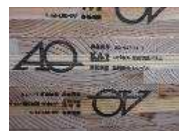
■ J パネル(CLT) 耐力壁 施工中
