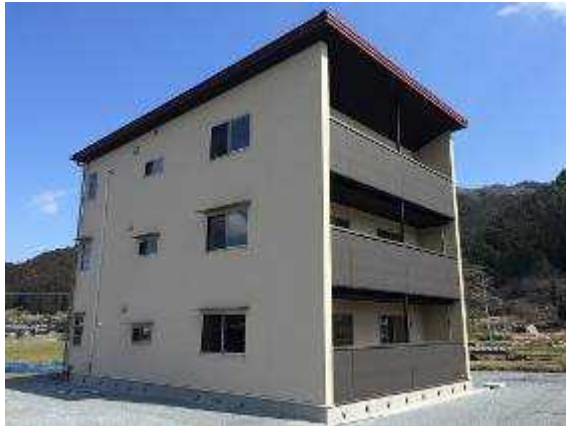
■全国初のCLTパネル工法の市営住宅写真
