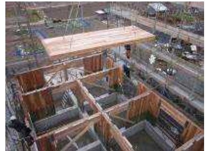
■CLTパネル工法の建て方
