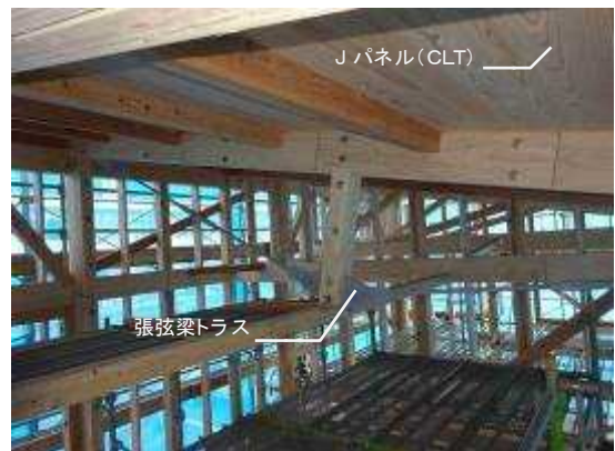
■ 張弦梁トラス (上) 構造図 (下) 施工中
