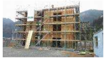
■CLTパネル工法の耐力壁
