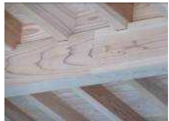
■渡り廊下 (写真右上・右下(手刻み加工))
