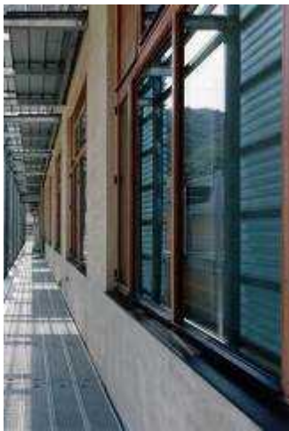
■エントランスホール (産桧集成材+複層ガラス)
