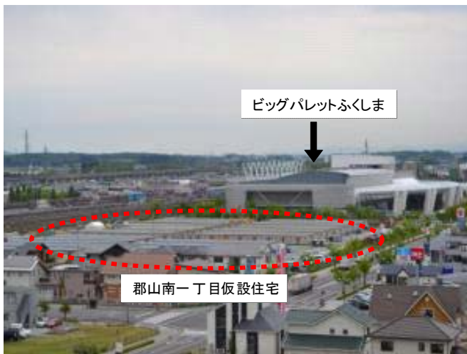
郡山市南一丁目仮設住宅遠景
