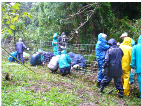
▲集落・住民による柵の設置作業
