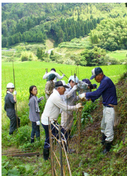
▲地元とイノシシ団の共同作業で侵入防止柵を設置
