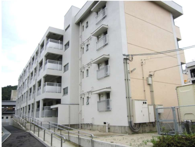
(外部スロープ・エレベーター設置)
