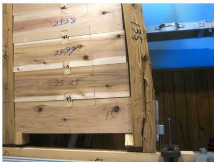
図-2 脆性破壊を起こした柱脚部
