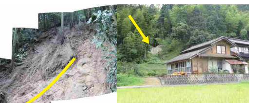
琴浦町の災害でも治山えん堤がつくられていた所では土砂災害から家が守られた。
