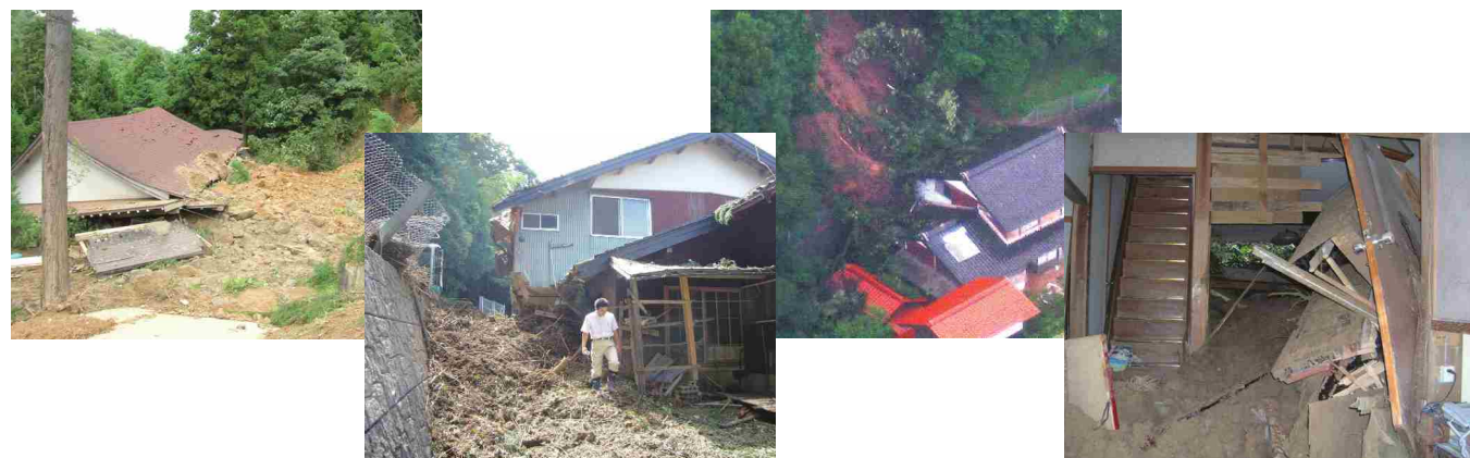
1時間に103mmの大雨が降り、がけ崩れが発生し、家に土砂が流れ込む。(負傷者1名、人家全壊2戸、半壊1戸)
