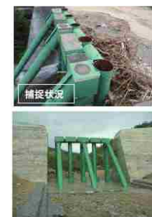
山口県防府市の災害でも砂防えん堤がつくられていた所では土石流をしっかりと受け止めていた。
