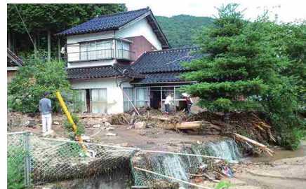
1時間に70mmの大雨が降り、土石流が発生し、家に土砂が流れ込む。(一部損壊1戸)
