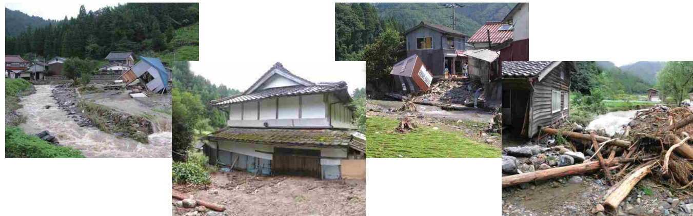
1時間に86mmの大雨が降り、土砂災害が発生。(人家半壊1戸、倉庫全壊3棟)
