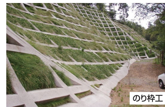
のり枠工、よう壁工の例(何千万円もかかる)
